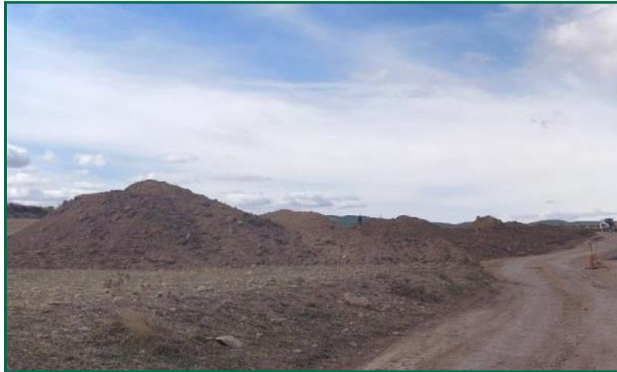
Fotografía 1. Caballones de tierra acopiados al comienzo de la obra.
