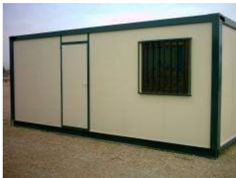
Imagen 15: Caseta provisional de Obra
