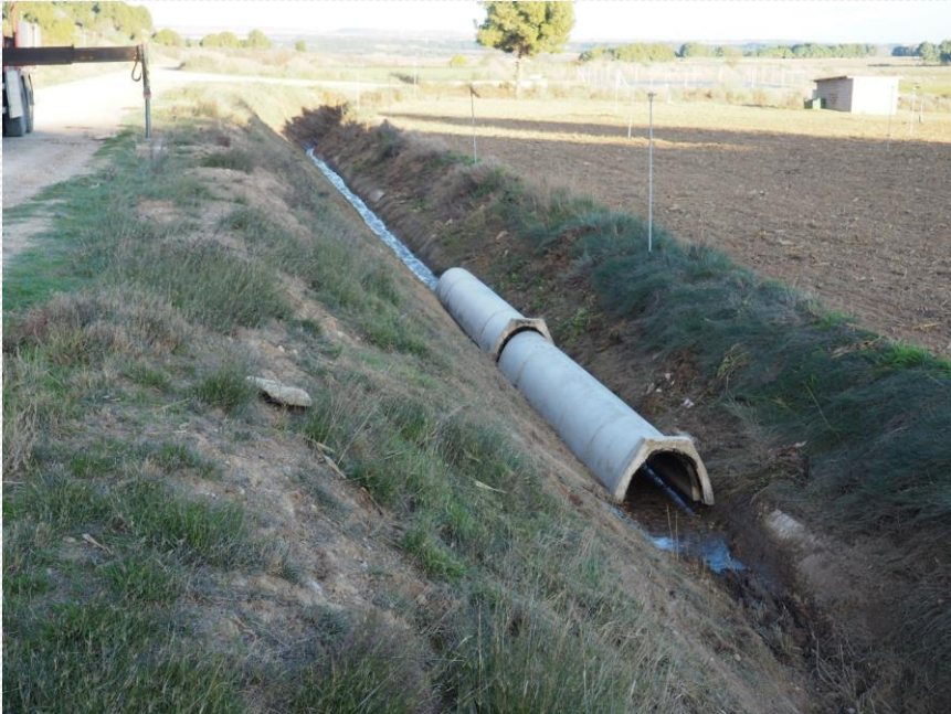
Fotografía 5 : Desagüe en CR San Juan con canaleta mediana
