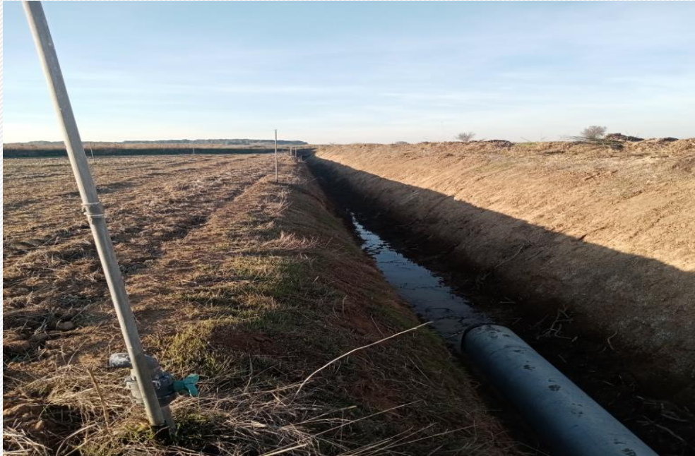
Fotografía 7 : Desagüe en Orillena en tierras con poca vegetación
