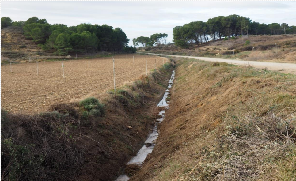
Fotografía 1: Desagüe en hormigón con poca vegetación previa, caudal agua +20 l/sg.
