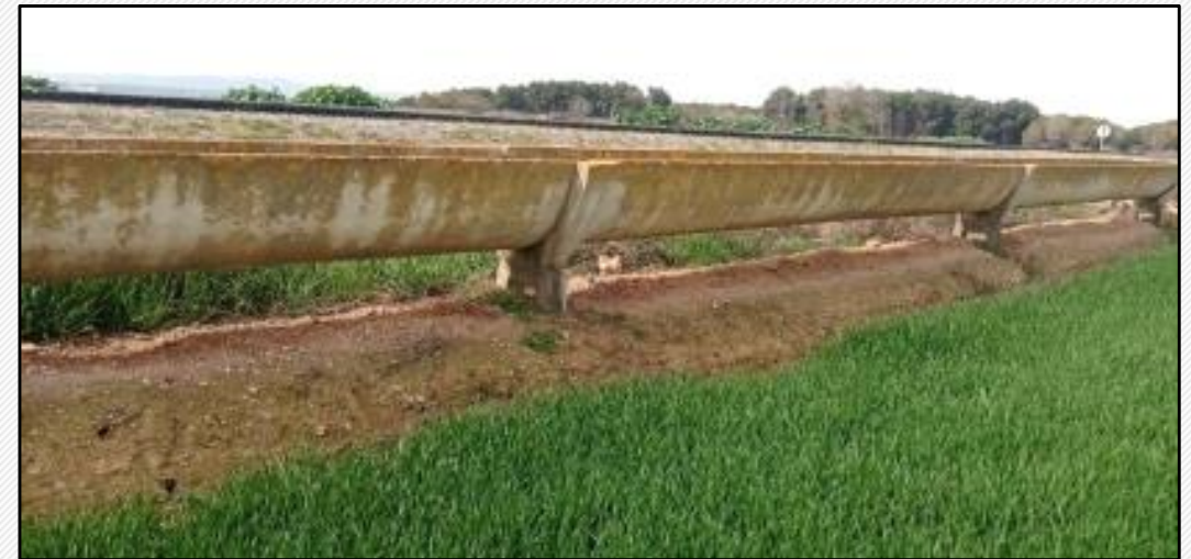
Foto 2. Canaleta Tipo A con alzado y solera
