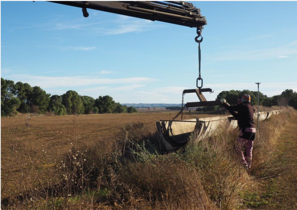
Fotografía 3: Desmontaje canaleta para trasladar a desagüe
