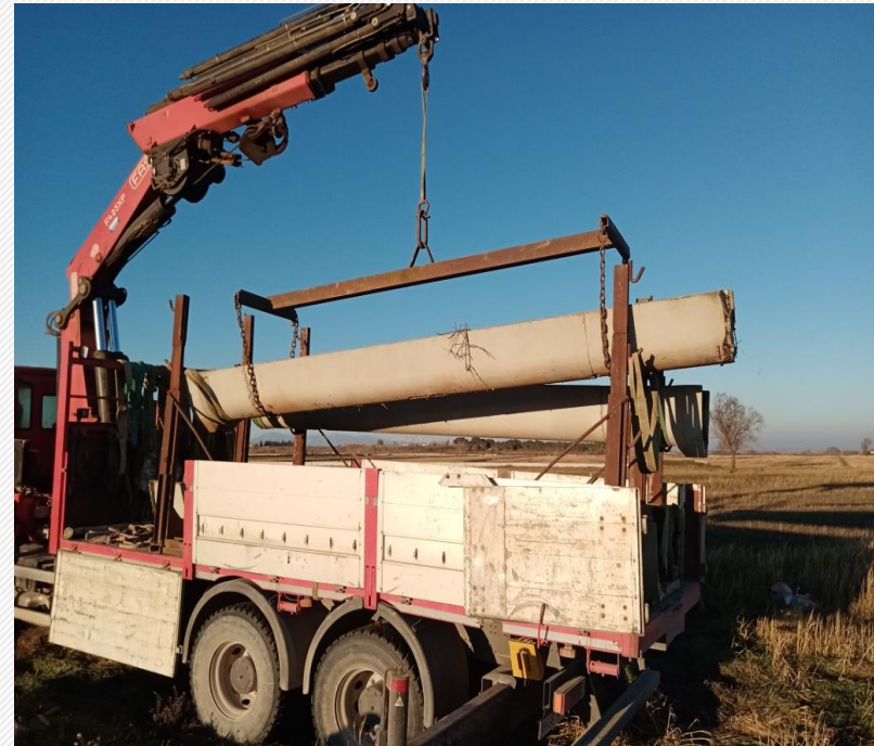
Fotografía 4 , Camión pluma con aparillaje traslado canaleta
