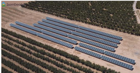
Instalación con seguidor
