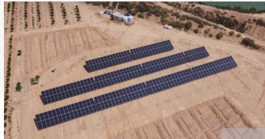
Instalación fija 2V 25°
