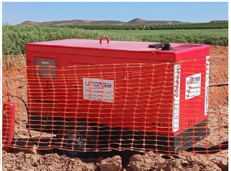
Figuras 1 y 2: Punto limpio provisional señalado (izqda) y generador eléctrico sobre plataforma antiderrames (dcha)
