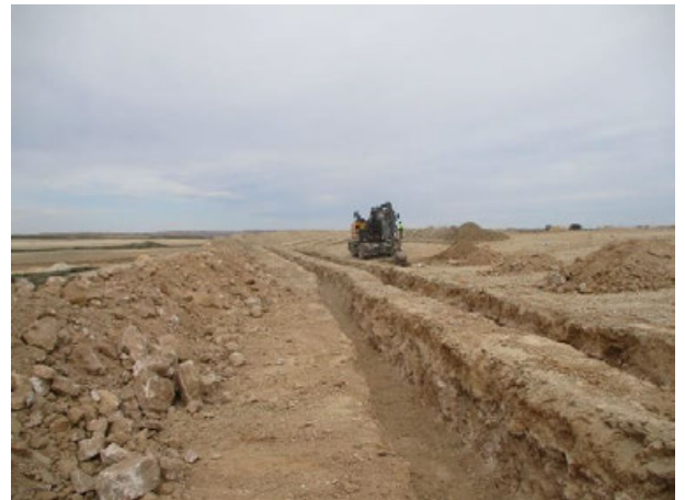
Imagen 8: Zanjeado en CT 3
