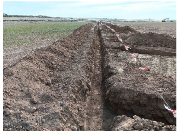
Imagen 6: Zanjeado en CT 2
