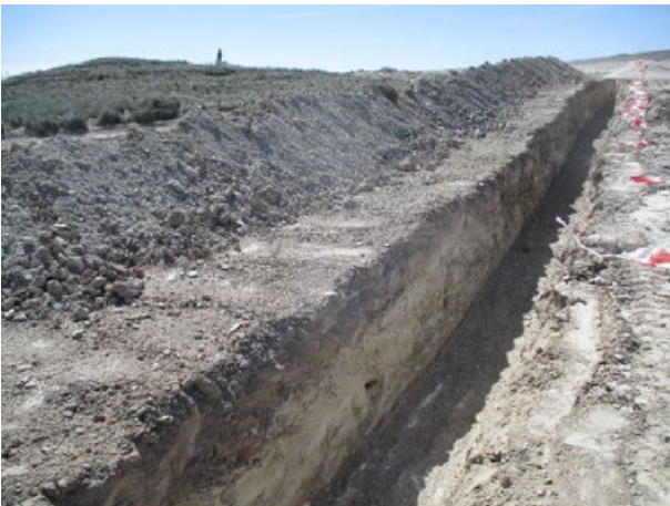
Imagen 7: Zanjeado en CT 3
