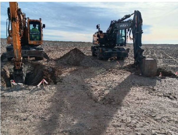
Imagen 1: Zanjeado en CT 4
