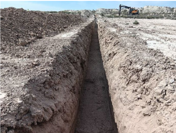
Imagen 7: Zanjeado en CT 2
