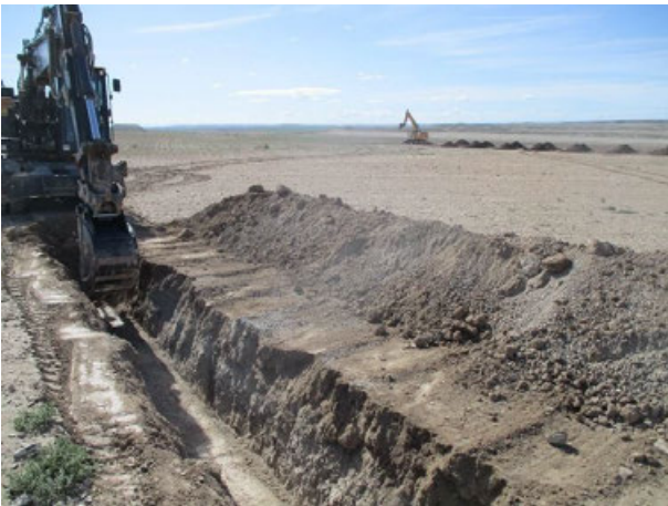
Imagen 3: Zanjeado en CT 4
