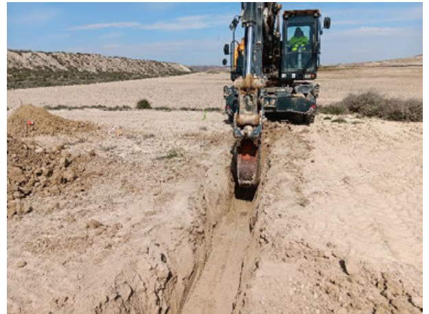
Imagen 8: Zanjeado en CT 2
