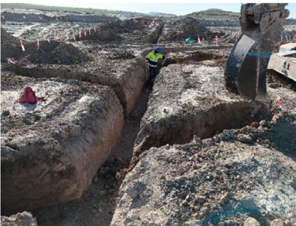
Imagen 5: Zanjeado en CT 3
