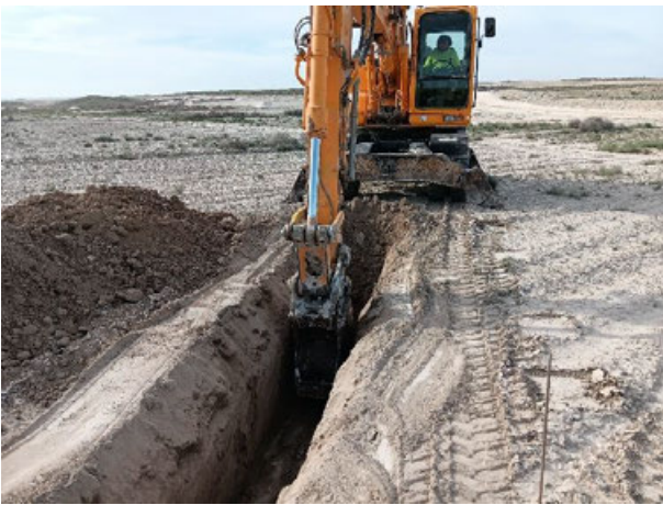
Imagen 5: Zanjeado en CT 2
