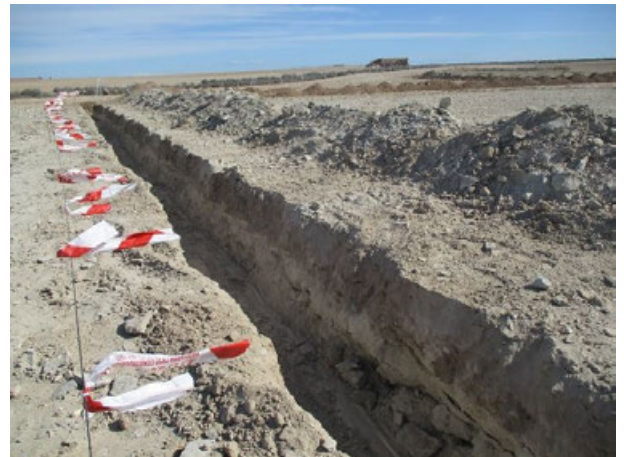
Imagen 4: Zanjeado en CT 4
