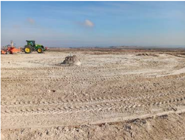
Imagen 1: Trabajos de nivelación en CT.1
