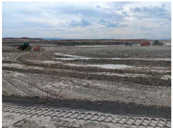
Imagen 4: Trabajos de nivelación en CT.2
