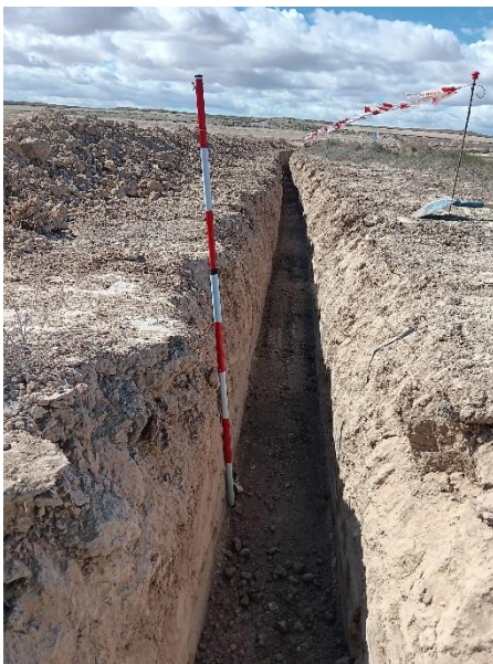
Imagen 5: Trabajos en la zanja perimetral
