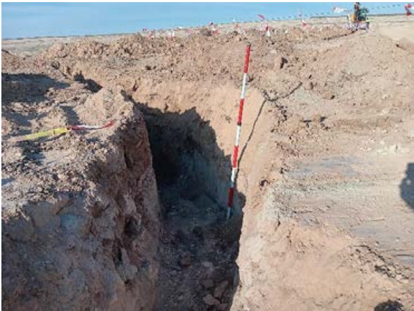
Imagen 11: Trabajos de zanjas en CT.5
