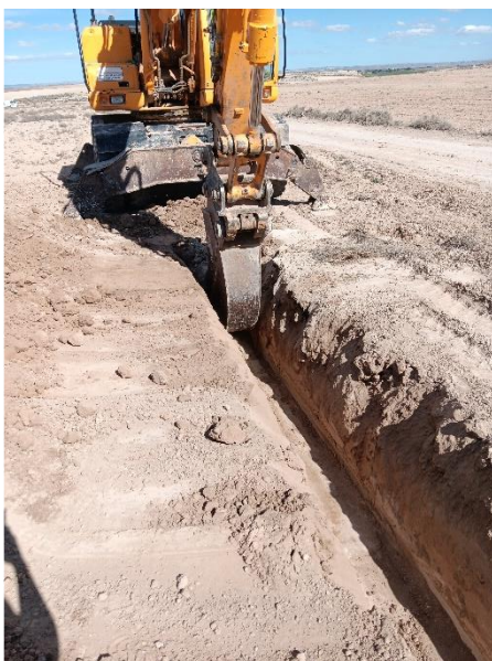
Imagen 7: Trabajos en la zanja perimetral
