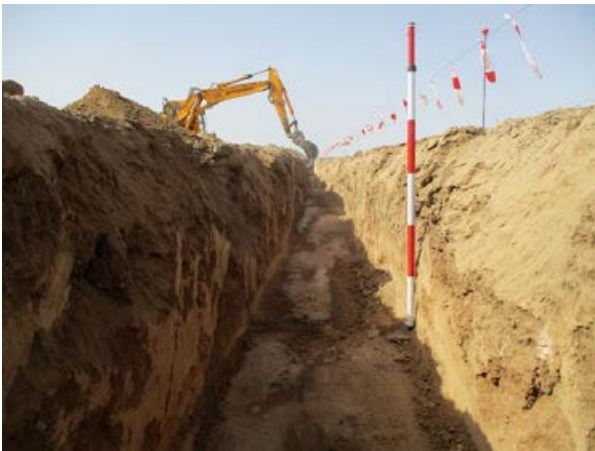
Imagen 9: Trabajos de zanjas en CT.6
