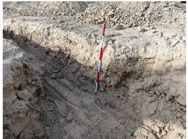
Imagen 14: Trabajos de zanjas en CT.5
