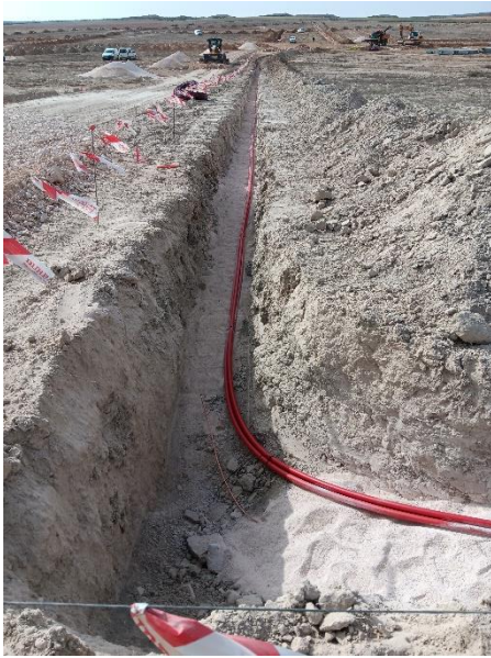
Imagen 13: Trabajos de zanjas en CT.5
