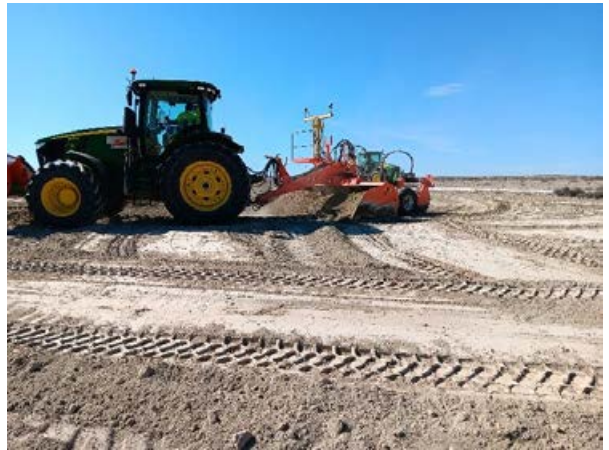
Imagen 2: Trabajos de nivelación en CT.1
