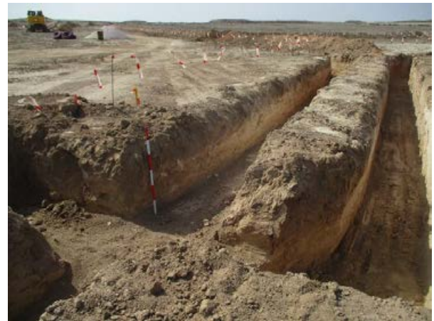
Imagen 10: Trabajos de zanjas en CT.6
