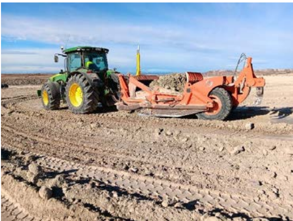
Imagen 3: Trabajos de nivelación en CT.2
