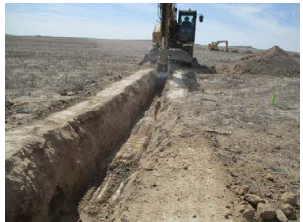
Imagen 8: Trabajos de zanjas en CT.6
