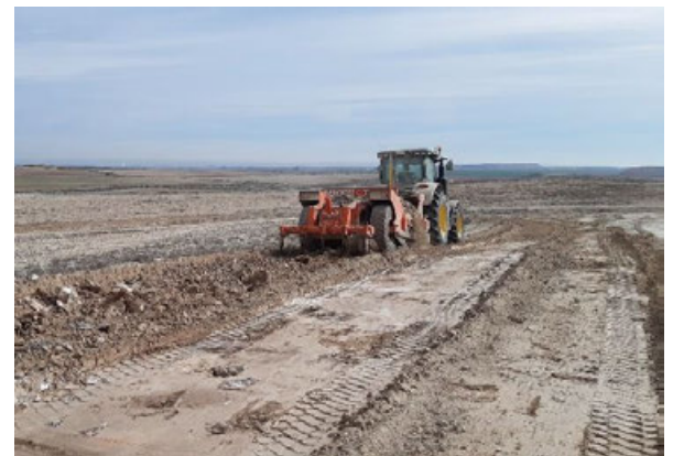
Imagen 8: Movimientos de tierras en CT.05
