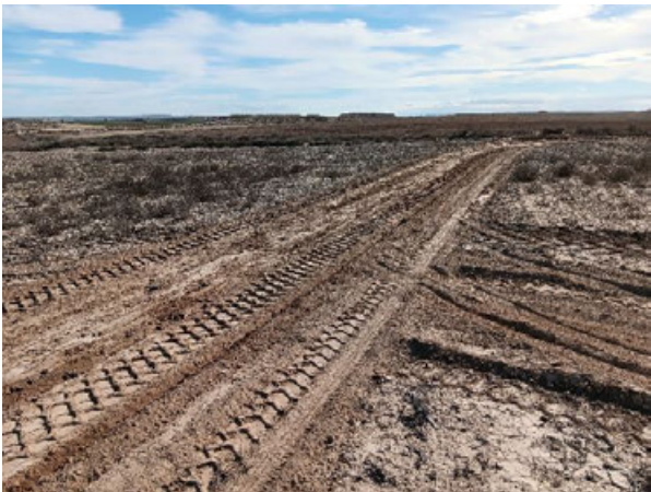
Imagen 3: Inicio de movimientos de tierras en CT.06
