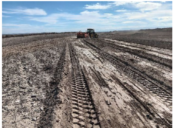
Imagen 4: Movimientos de tierras en CT.06
