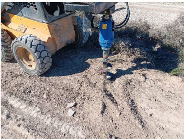
Imagen 15: Trabajos de excavación de los hoyos de poste
