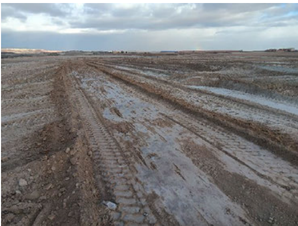
Imagen 11: Trabajos de nivelación en CT.04
