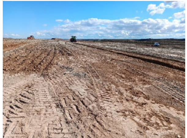
Imagen 14: Trabajos de nivelación en CT.04
