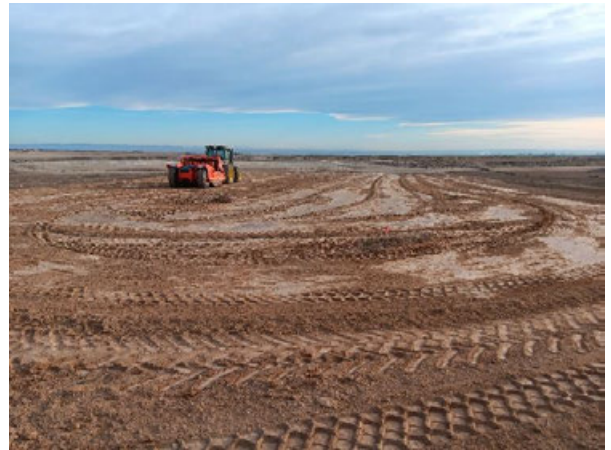
Imagen 6: Últimos movimientos de tierras en CT.06
