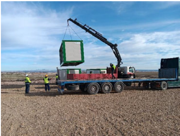
Imagen 1: Instalación del Site Camp
