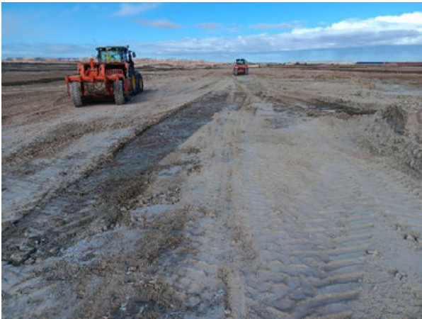
Imagen 13: Trabajos de nivelación en CT.04
