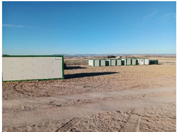
Imagen 2: Instalación del Site Camp
