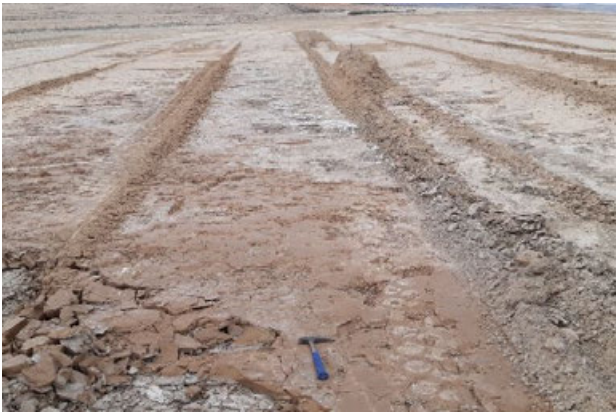
Imagen 9: Movimientos de tierras en CT.05
