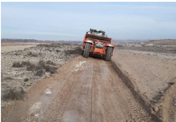
Imagen 7: Inicio de movimientos de tierras en CT.05
