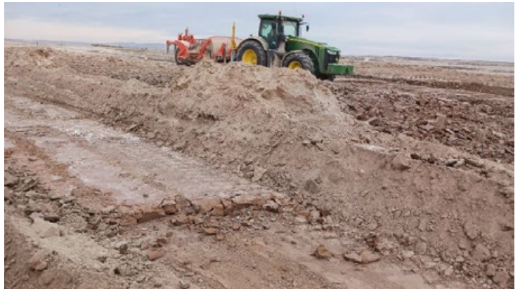
Imagen 10: Movimientos de tierras en CT.05
