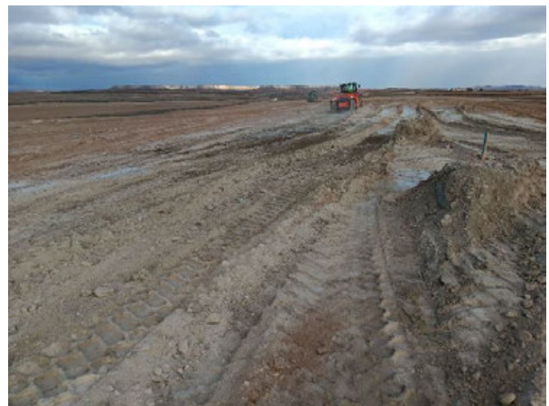
Imagen 12: Trabajos de nivelación en CT.04
