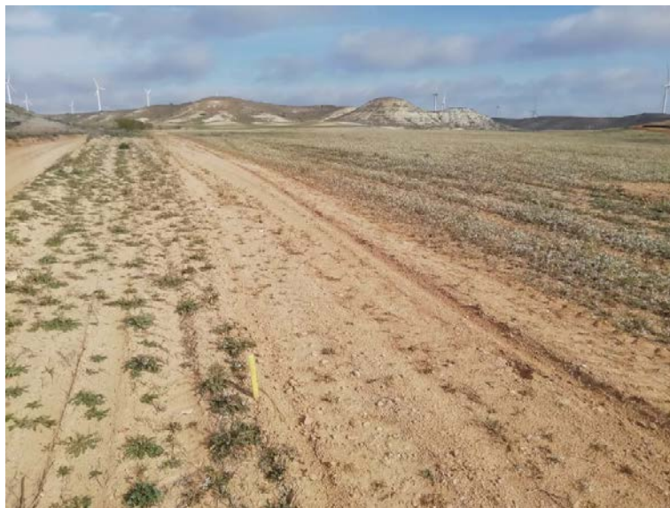
Figura 2: Desbroce en vallado perimetral.
