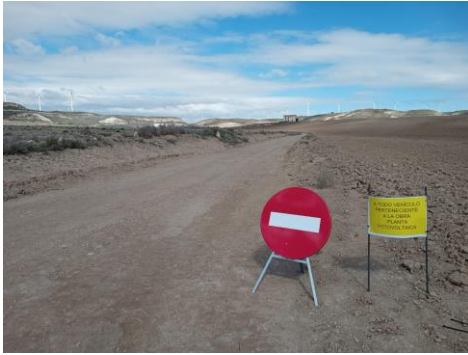
Figura 7. Señal provisional de prohibido el paso a vehículos de obra en camino de acceso al primillar desde Navaros I y II
