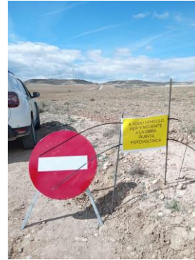
Figura 8. Señal provisional de prohibido el paso a vehículos de obra en camino de acceso al primillar desde Jalón I
