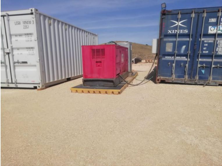
*Figura 1: Grupo electrógeno con cubeto de retención*
