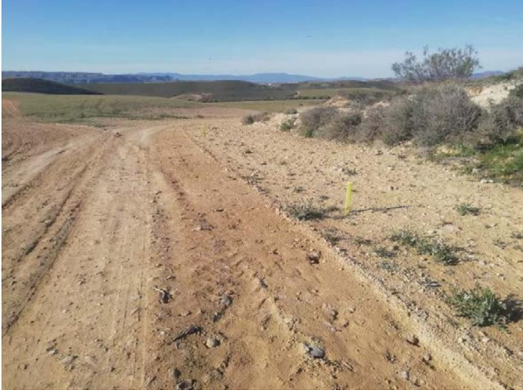
*Figura 1: Jalonamiento de la obra con estacas.*
