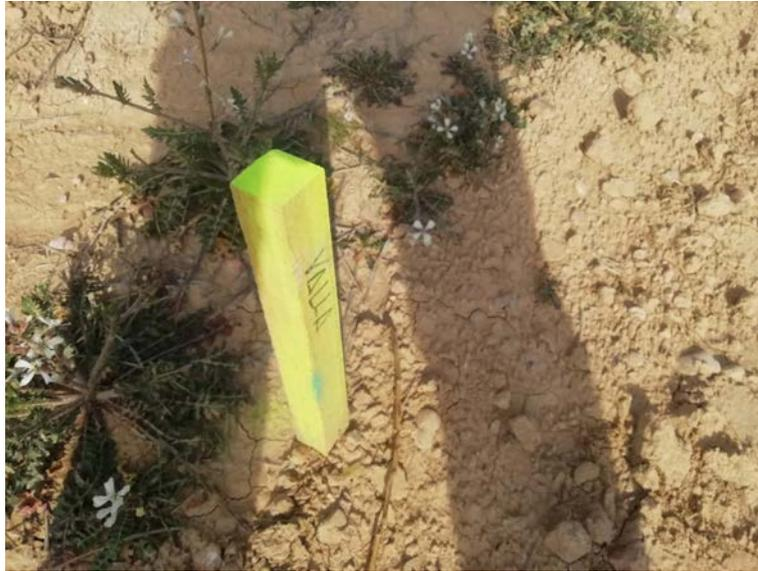
*Figura 1: Estaca marcando la ubicación del vallado.*
