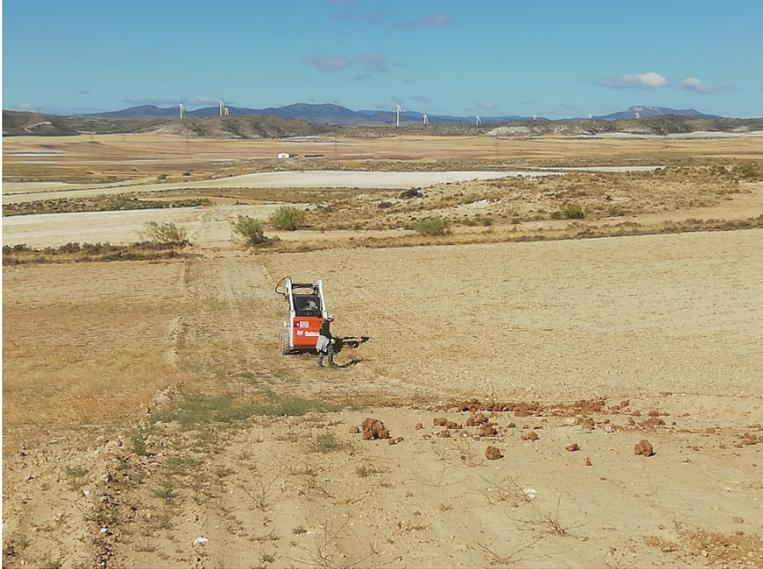
*Figura 1: Maquinaria realizando agujeros para el vallado perimetral.*
