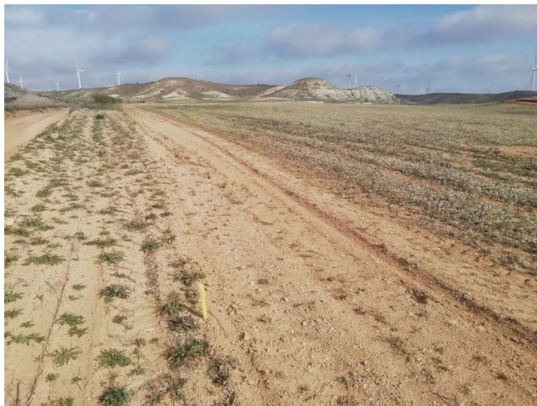
Figura 2: Desbroce en vallado perimetral.
