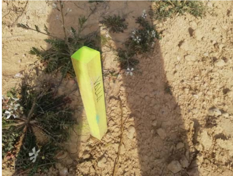
Figura 1: Estaca marcando la ubicación del vallado.
