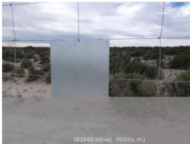
Ilustración 7. Placa anticollisión del vallado permeable.
