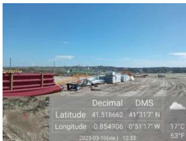
Ilustración 3. Zona de parking y acopio de material.
