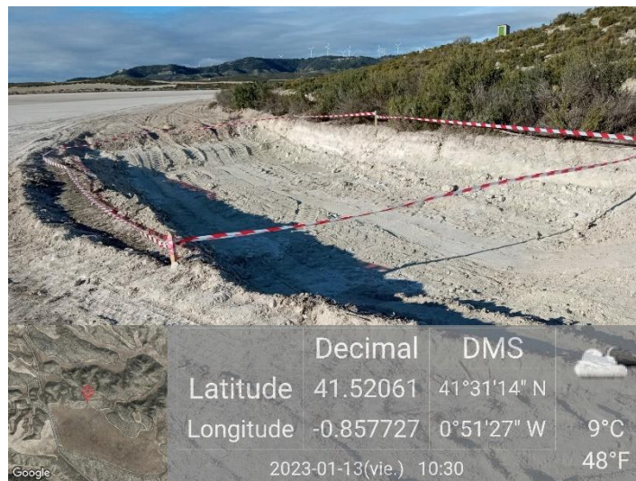
Ilustración 3: Balsa de hormigón excavada en la poligonal sur.
