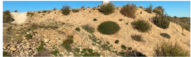
Estado general de los taludes restaurados (T-14)
