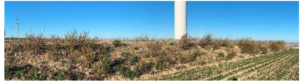
Estado general de los taludes restaurados (T-10)
