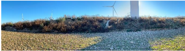
Estado general de los taludes restaurados (T-07)
