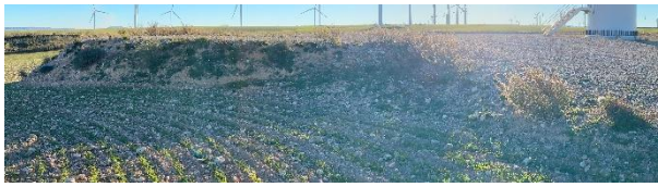
Estado general de los taludes restaurados (T-04)
