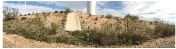
Estado general de los taludes restaurados (T-06)
