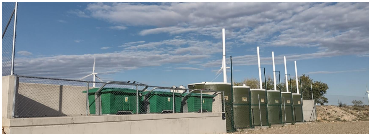
Contenedores para almacenamiento y autohidrólisis de cadáveres de porcino, ubicados en el núcleo ganadero
