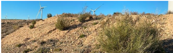
Estado general de los taludes restaurados (T-13)
