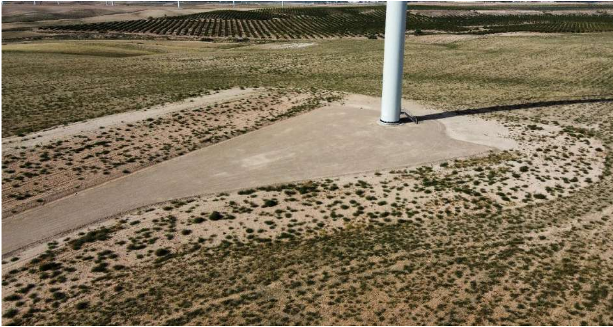
Foto nº3.: Plataforma del Aerogenerador REII-03.
