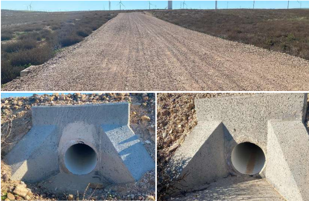
Foto nº9.: Drenaje de vial.
