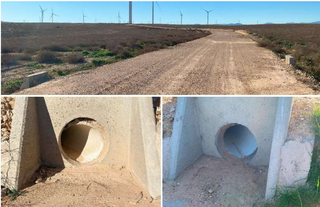
Foto nº10.: Drenaje de vial.
