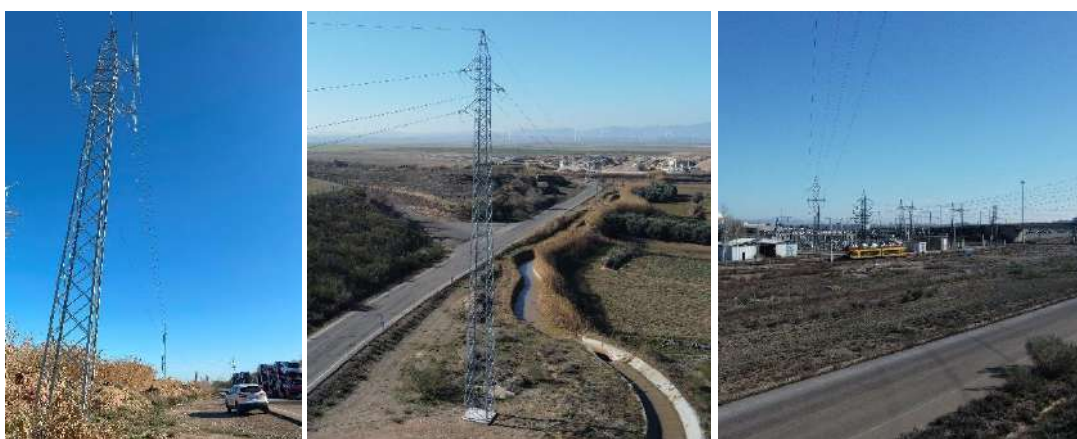
Foto nº6.: Estado general de los apoyos. Apoyo nº 5, Apoyo nº 6 y Apoyo nº 7 punto final de la LAAT.
