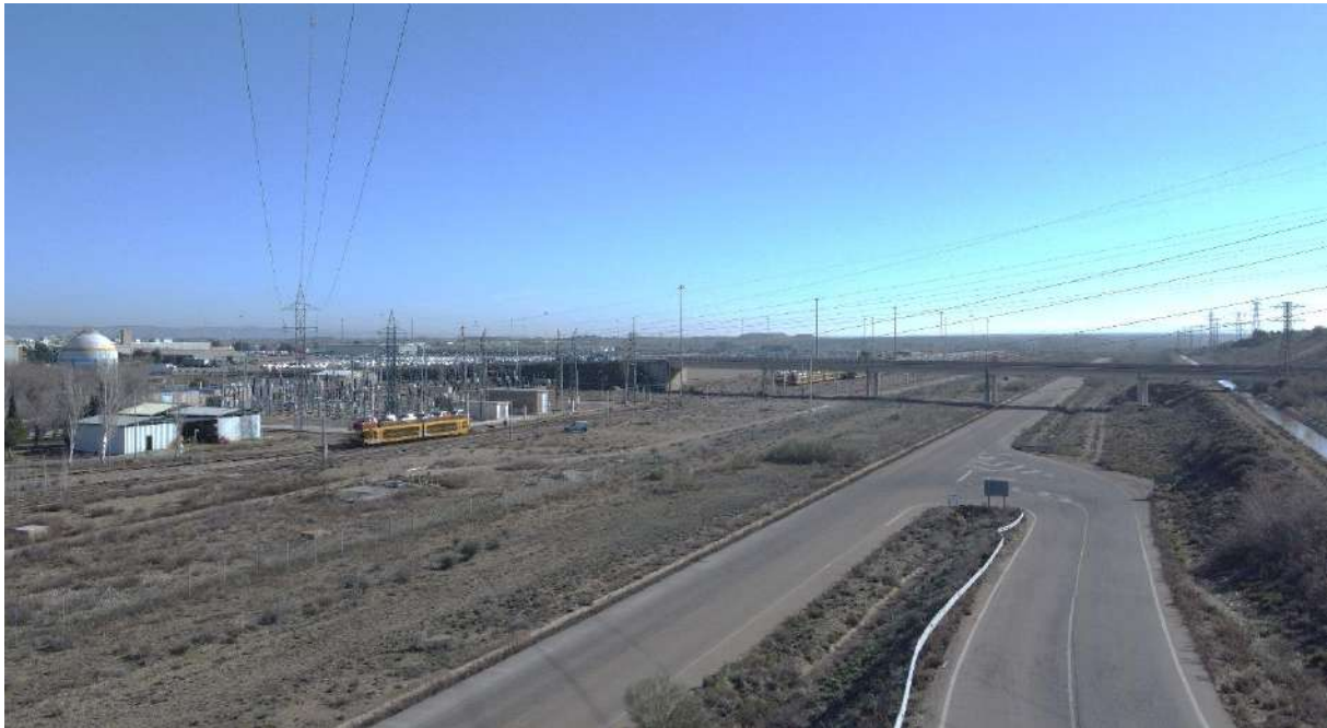
Foto nº8.: SET Entrerriós. Punto final de la LAAT.
