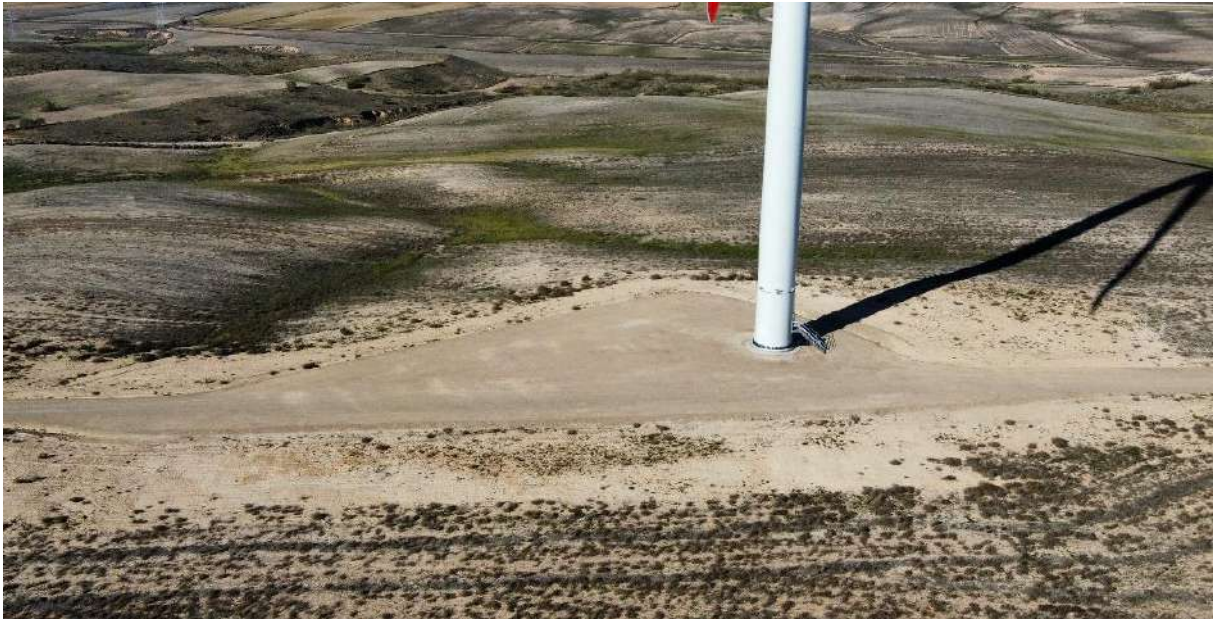
Foto nº1.: Plataforma del Aerogenerador REII-01.
