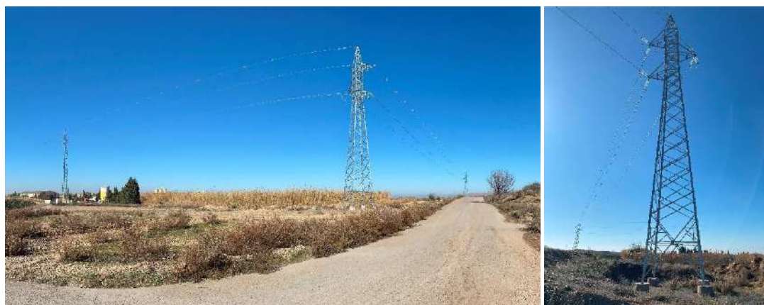
Foto nº5.: Estado general de los apoyos. Apoyo nº 3 y Apoyo nº 4 de la LAAT.
