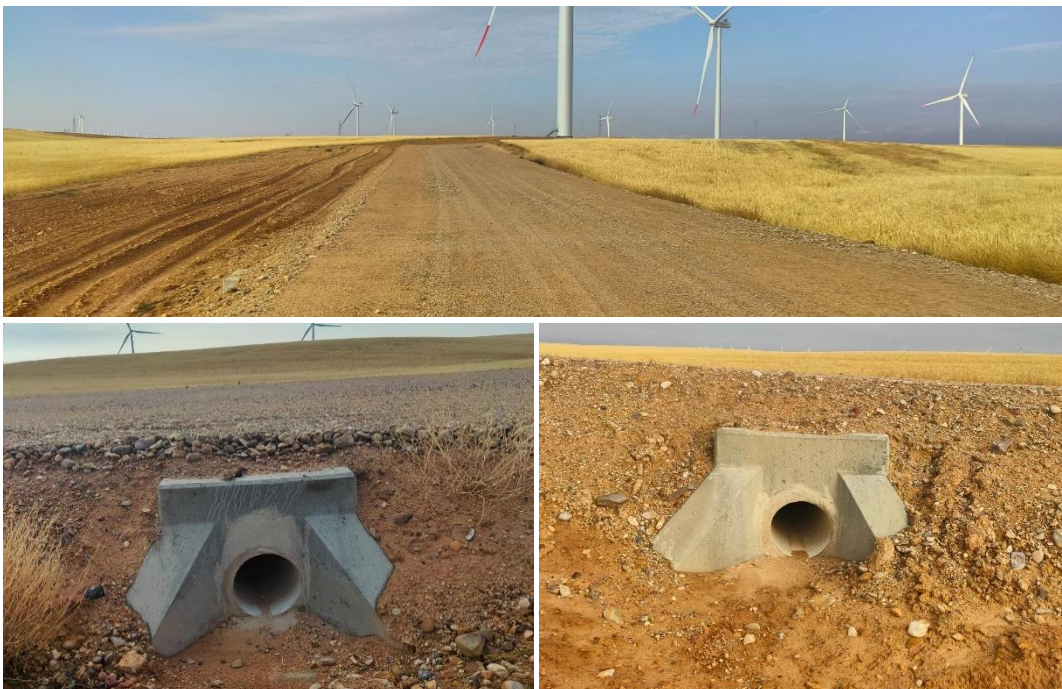
Foto nº11.: Drenaje de vial.
