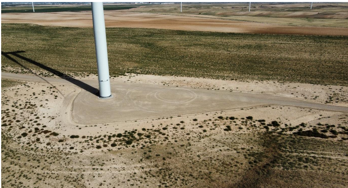
Foto nº1.: Plataforma del Aerogenerador REII-01.
