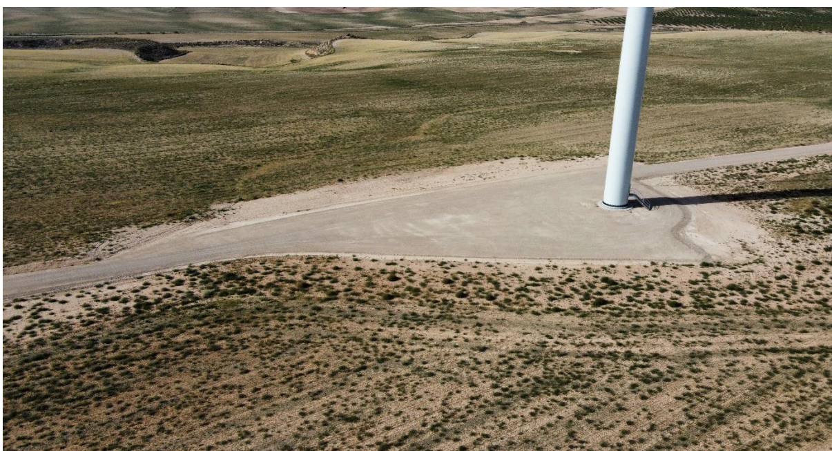
Foto nº2.: Plataforma del Aerogenerador REII-02.
