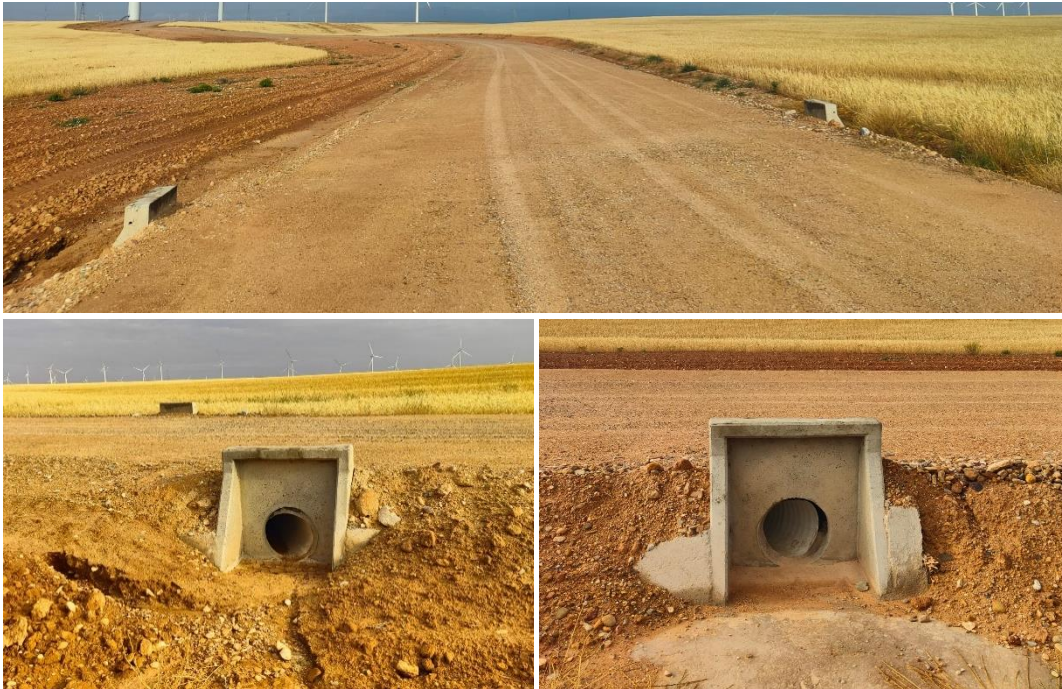
Foto nº10.: Drenaje de vial.
