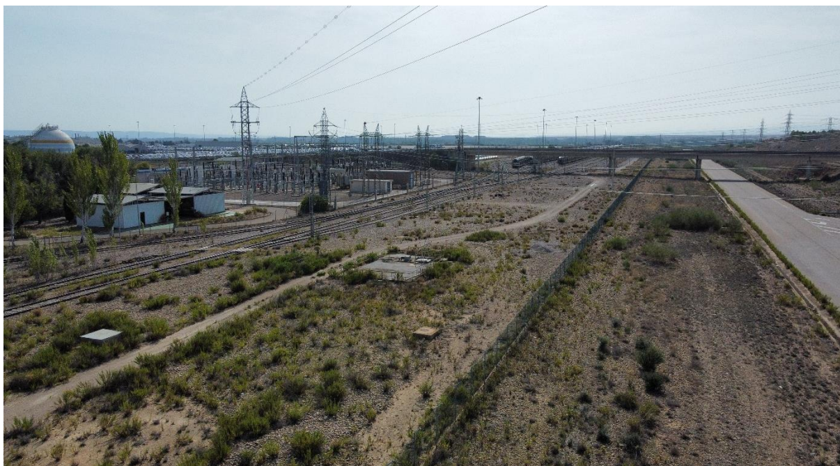
Foto nº9.: SET Entrerriós. Punto final de la LAAT.
