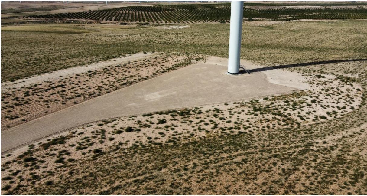
Foto nº3.: Plataforma del Aerogenerador REII-03.
