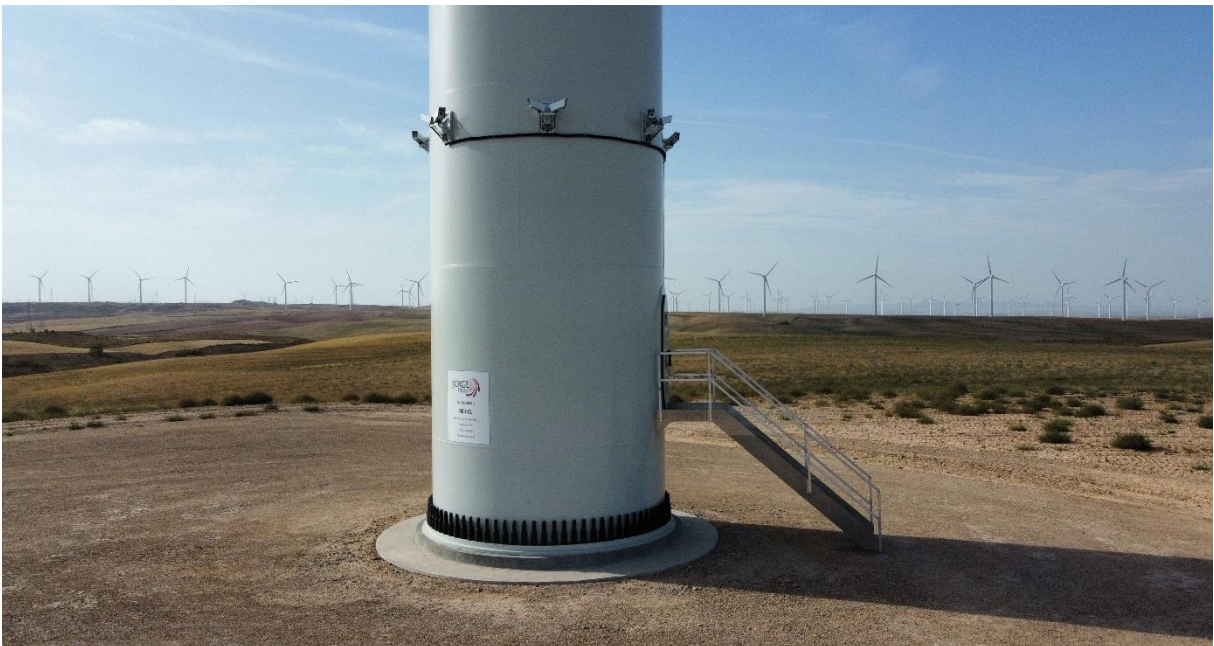
Foto nº4.: Instalación Dispositivo 3DObserver en Aerogenerador REII-01.
