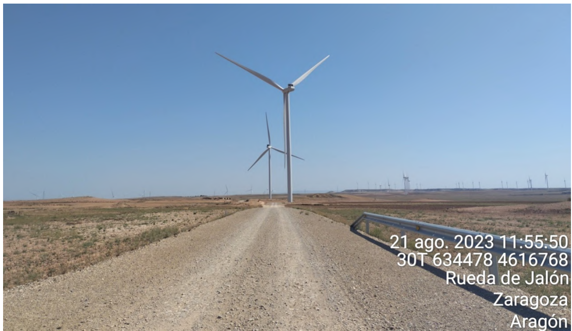
Figura 5: Vial de acceso principal entre aerogeneradores ET8 (aerogenerador más cercano de la imagen) y ET7.
