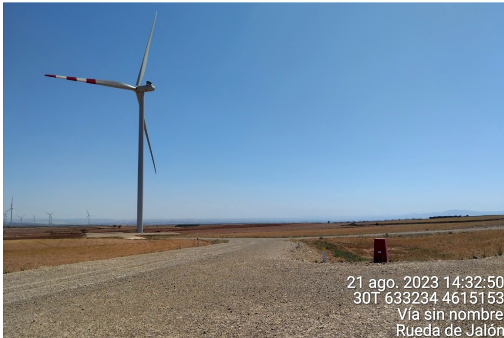
Figura 7: Estado de los viales de acceso al aerogenerador ET-2 y 3 hacia ET-4.
