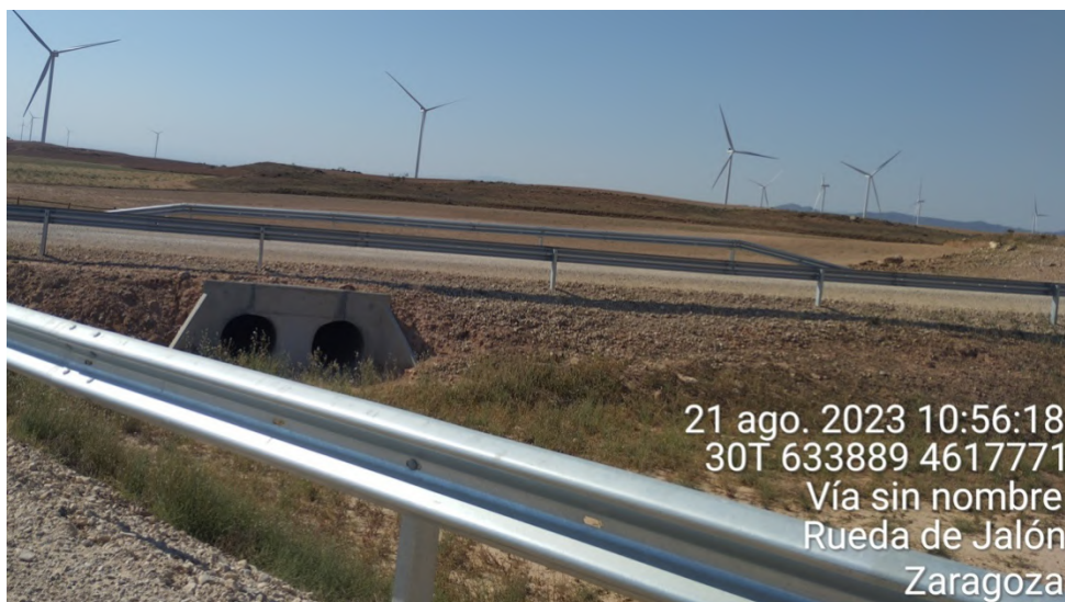
Figura 9: Desagüe situado en vial próximo a aerogeneradores ET11 y ET12 en buen estado de conservación.
