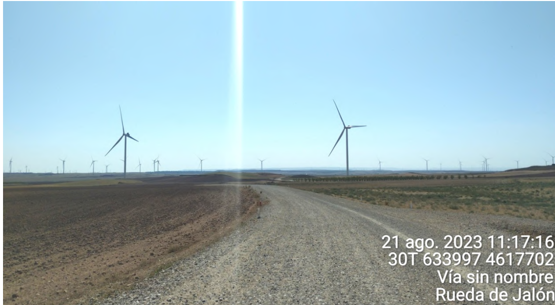
Figura 4: Vial de acceso a los aerogeneradores ET-11 y ET-12.
