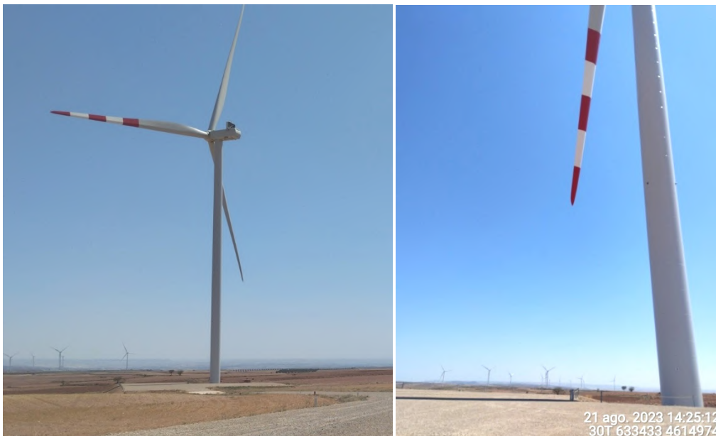
Figura 9: Fotografías del pintado de la pala de los aerogeneradores en PE “El Tollo” durante el presente cuatrimestre. En la imagen aerogeneradores ET-3 (izquierda) y ET-4 (derecha).
