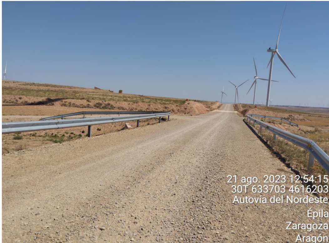
Figura 6: Vial de acceso principal entre aerogeneradores ET7 y ET6.
