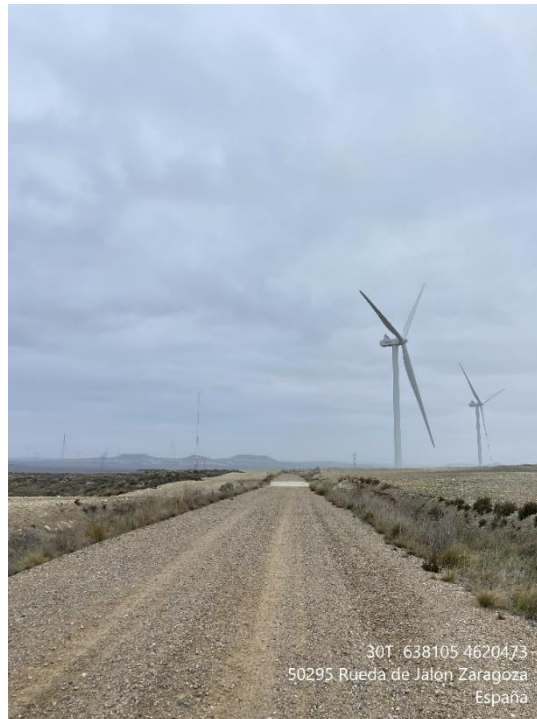
Figura 28: Vial y taludes de acceso a ELL-12 y ELL-11 en correcto estado de conservación.
