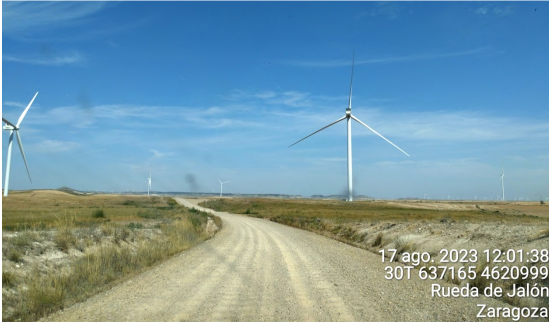
Figura 32: Vial y taludes de acceso a ELL-9 y 8 en correcto estado de conservación.
