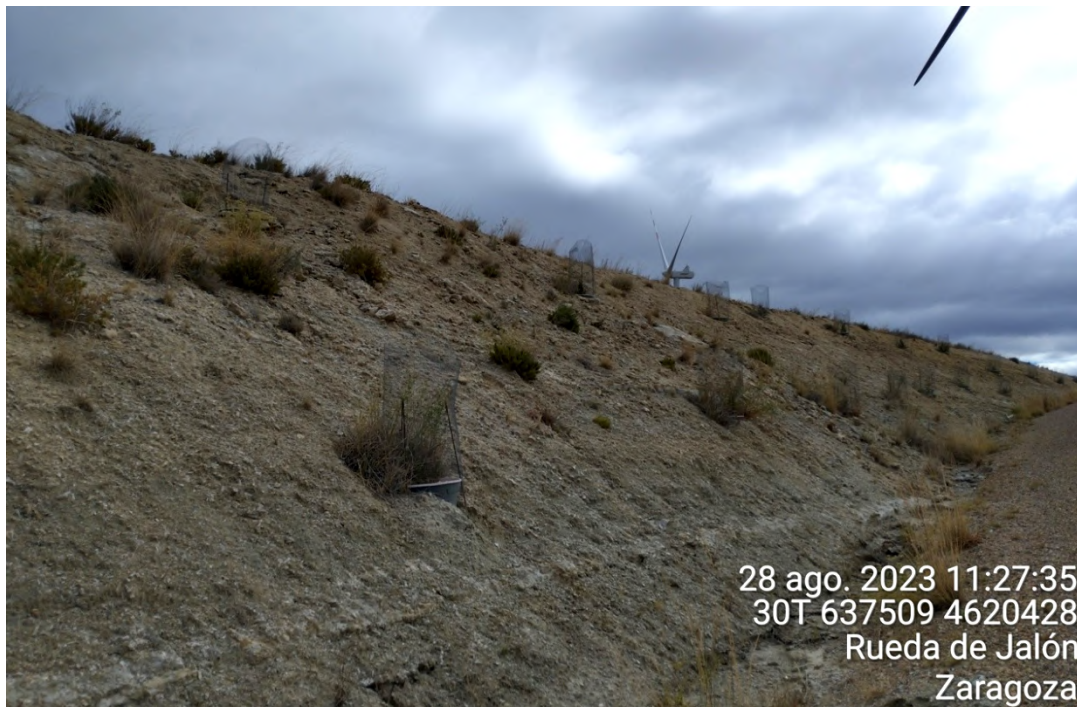
Figura 27: Plantaciones de waterbox en los taludes del vial entre ELL-6 y ELL-5, en correcto estado.
