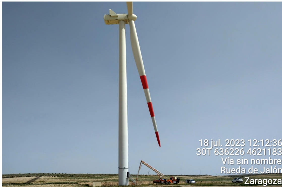
Figura 14: Foto del proceso de pintado de la pala del aero ELL-7 en julio de 2023.
