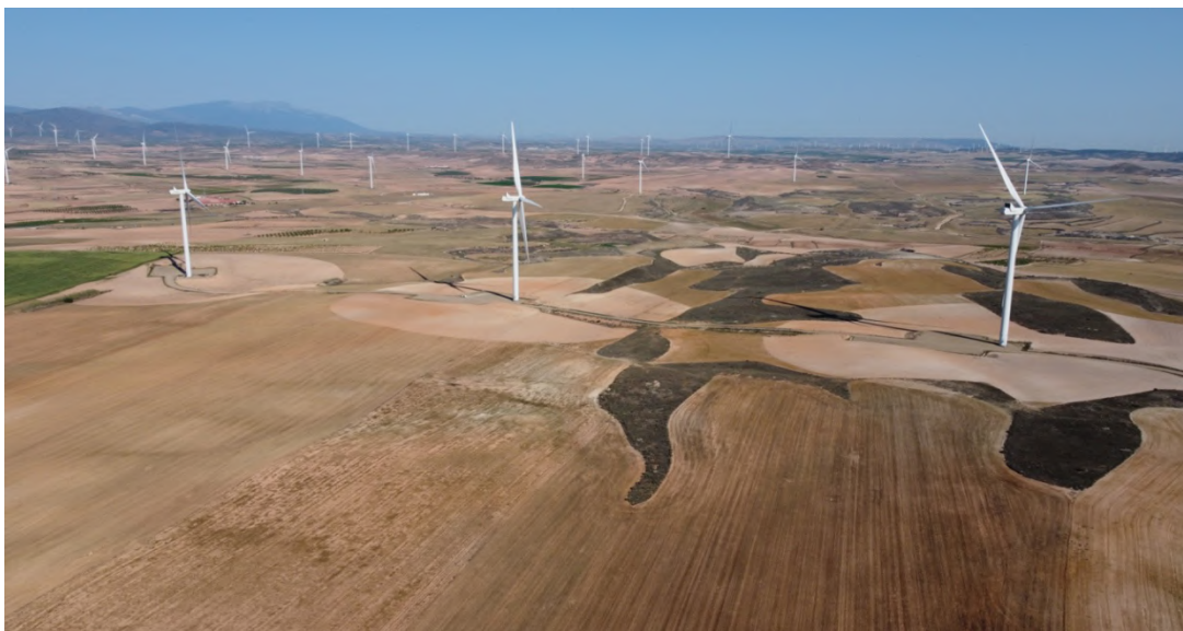
Figura 10: Plano general de las áreas ya labradas de aerogeneradores ELL-1, 2 y 3.
