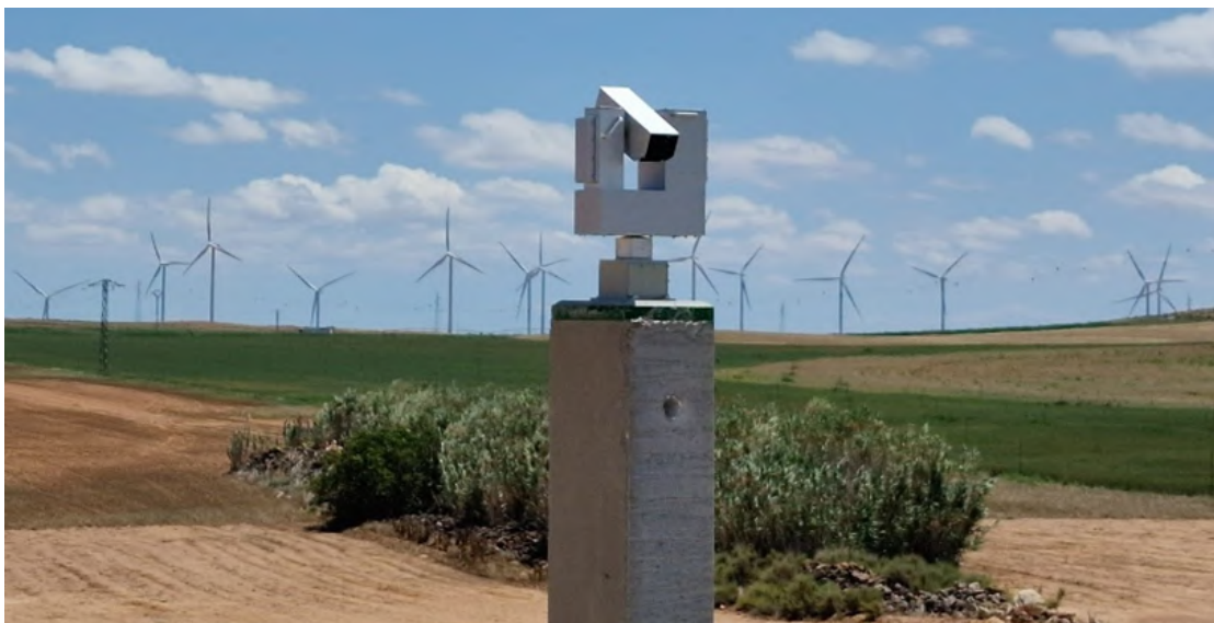
Figura 9: Fotografía de la cámara del sistema P-Tilt, instalada en junio en ELL-1.
