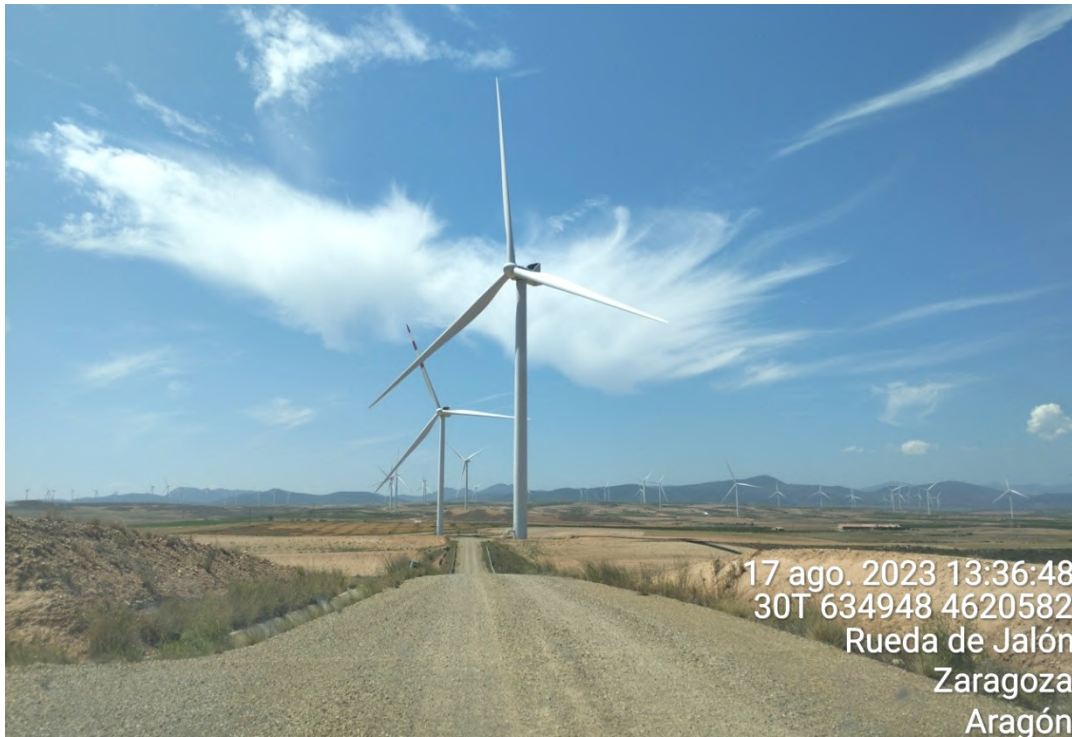
Figura 30: Vial y taludes de acceso a ELL-2 y ELL-3 en correcto estado de conservación.
