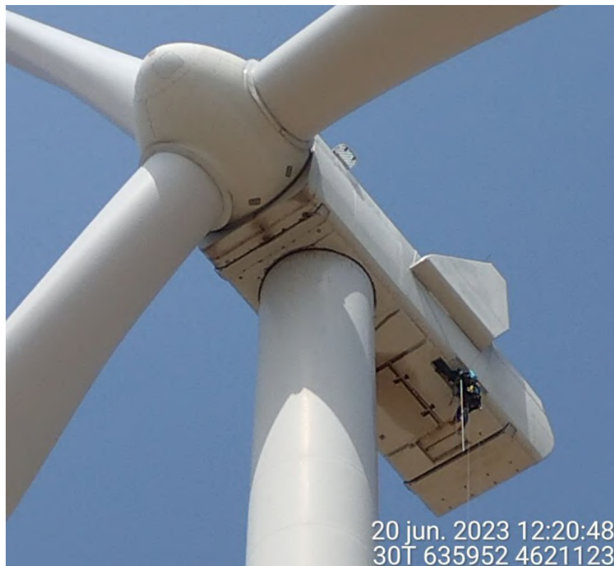
Figura 15: Operación de tapado de las nacelles en ET-7 el 20 de junio de 2023.
