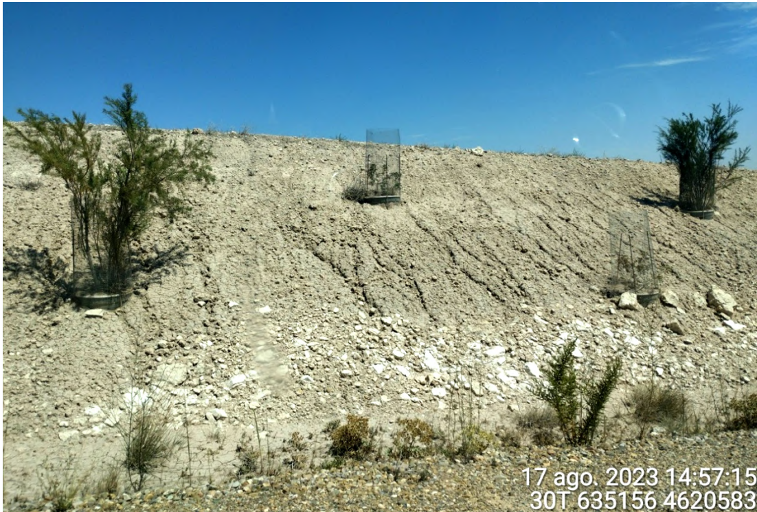
Figura 26: Plantaciones de waterbox realizadas en la cuesta del vial entre ELL-4 y ELL-3, en correcto estado.
