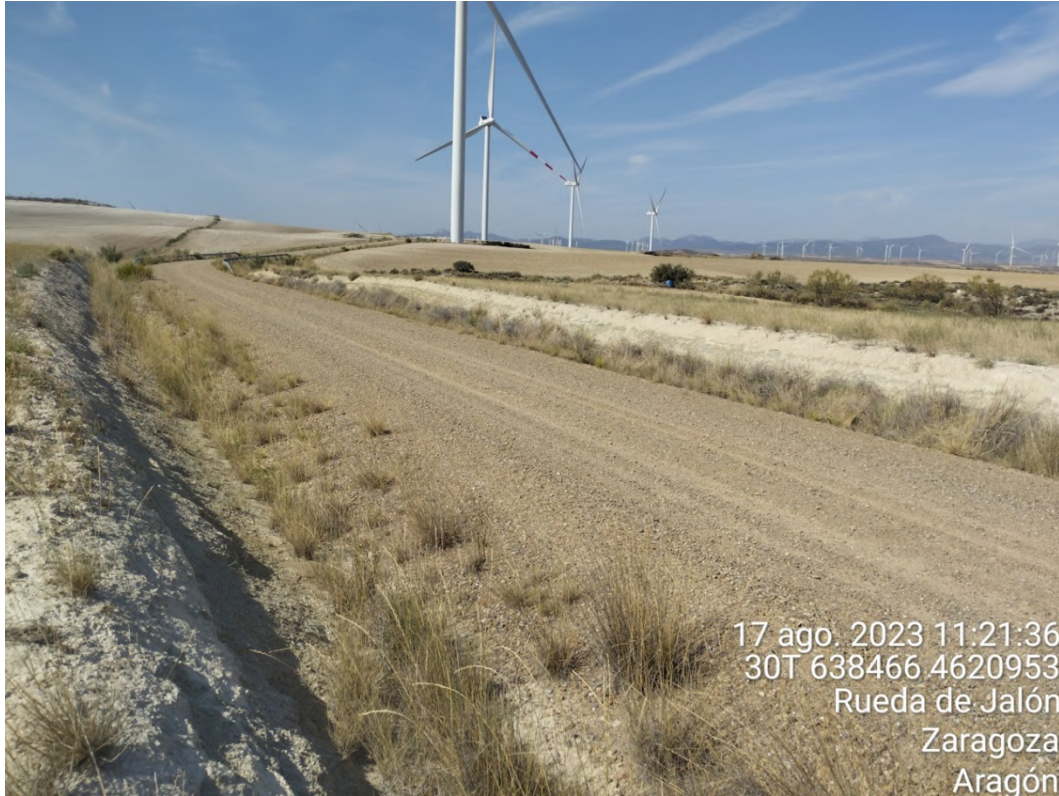
Figura 34: Vial y taludes de acceso a ELL-13 y 14 en correcto estado de conservación.
