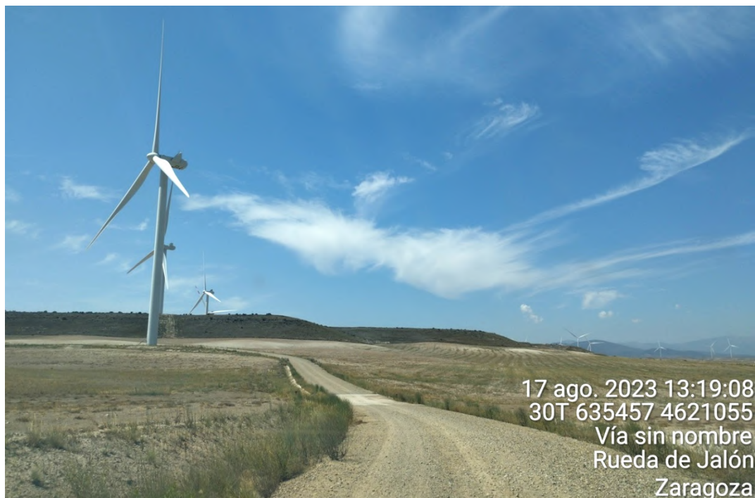
Figura 31: Vial y taludes de acceso a ELL-4 y ELL-5 en correcto estado de conservación.
