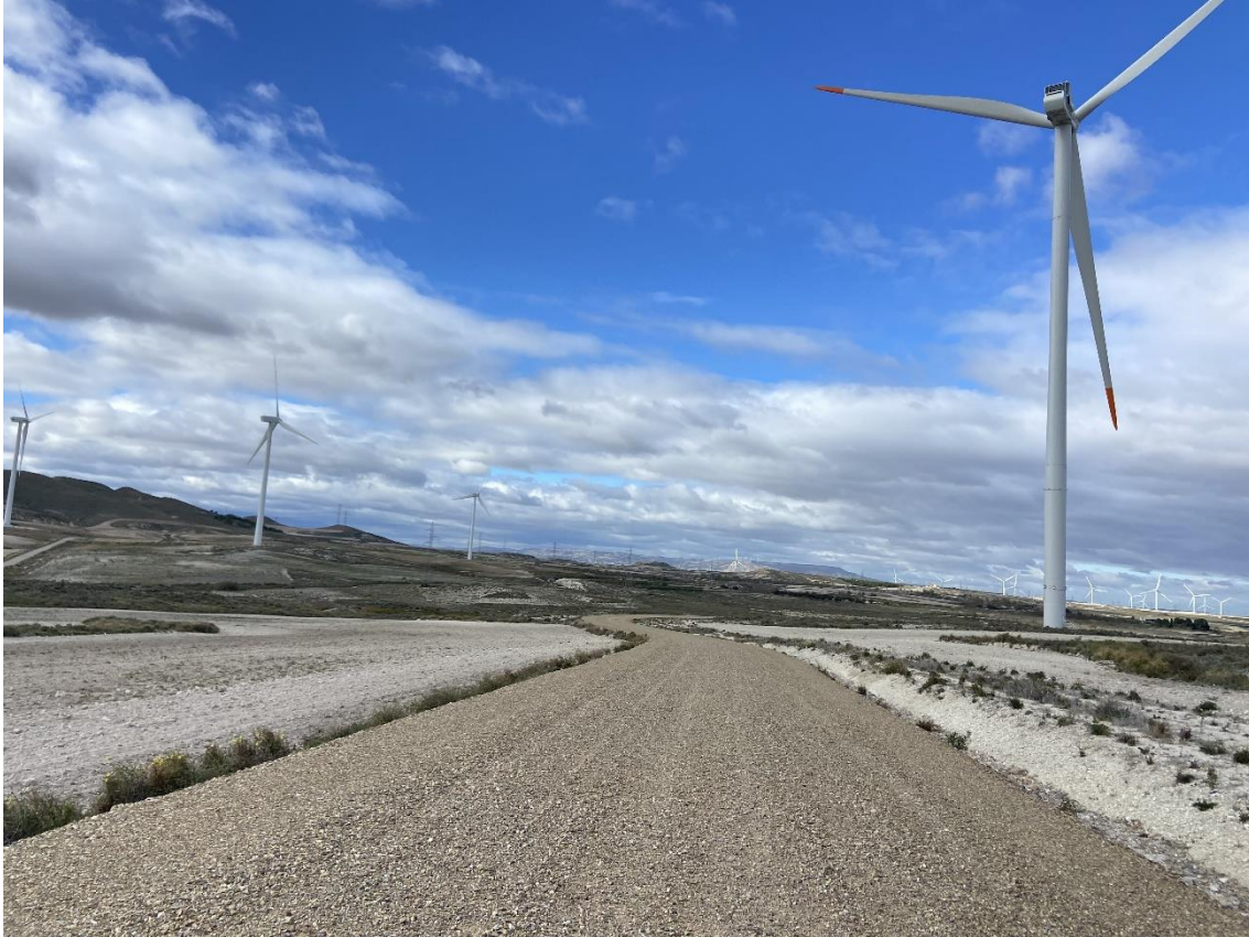
Figura 12: Vial perteneciente al Aerogenerador CDM-02.
