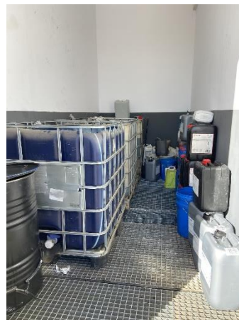
Figura 15: Interior del almacén de residuos de la SET “Campo de Magallón”, con los diferentes residuos peligrosos clasificados, aislados de la intemperie y sobre una tarima aislante para evitar posibles filtraciones al suelo.
