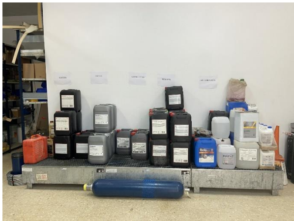
Figura 15: Interior del almacén de residuos de la SET “Campo de Magallón”, con los diferentes residuos peligrosos clasificados, aislados de la intemperie y sobre una tarima aislante para evitar posibles filtraciones al suelo.
