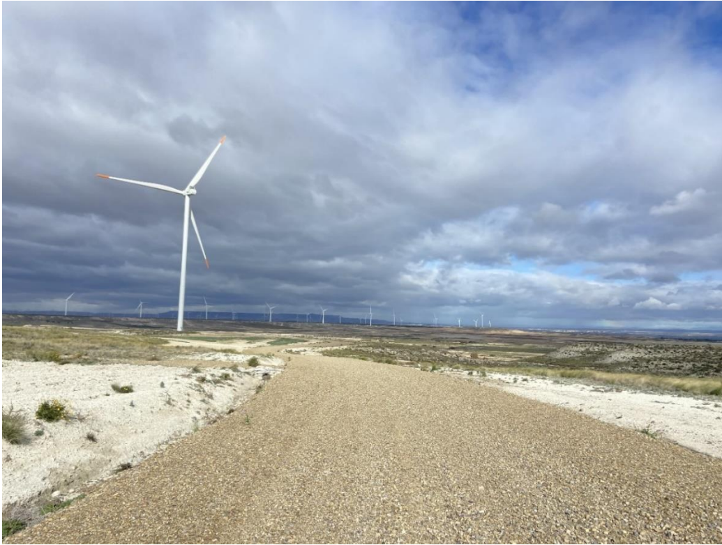
Figura 13: Vial perteneciente al Aerogenerador CDM-01. Se puede observar las medidas complementarias implementadas (pintado de palas)
