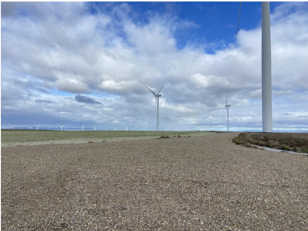
Figura 14: Vial perteneciente al Aerogenerador CDM-03. Se puede observar las medidas complementarias implementadas (pintado de palas)
