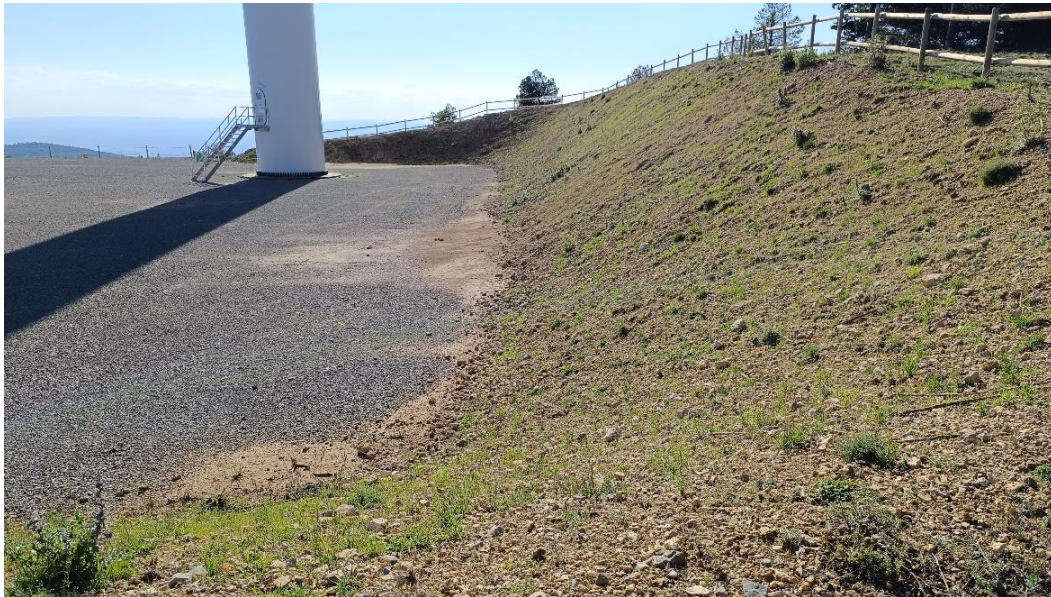
Figura 11. Aspecto de los taludes al principio del verano con brotes apreciables de las plantas sembradas durante los trabajos de hidrosiembra.
