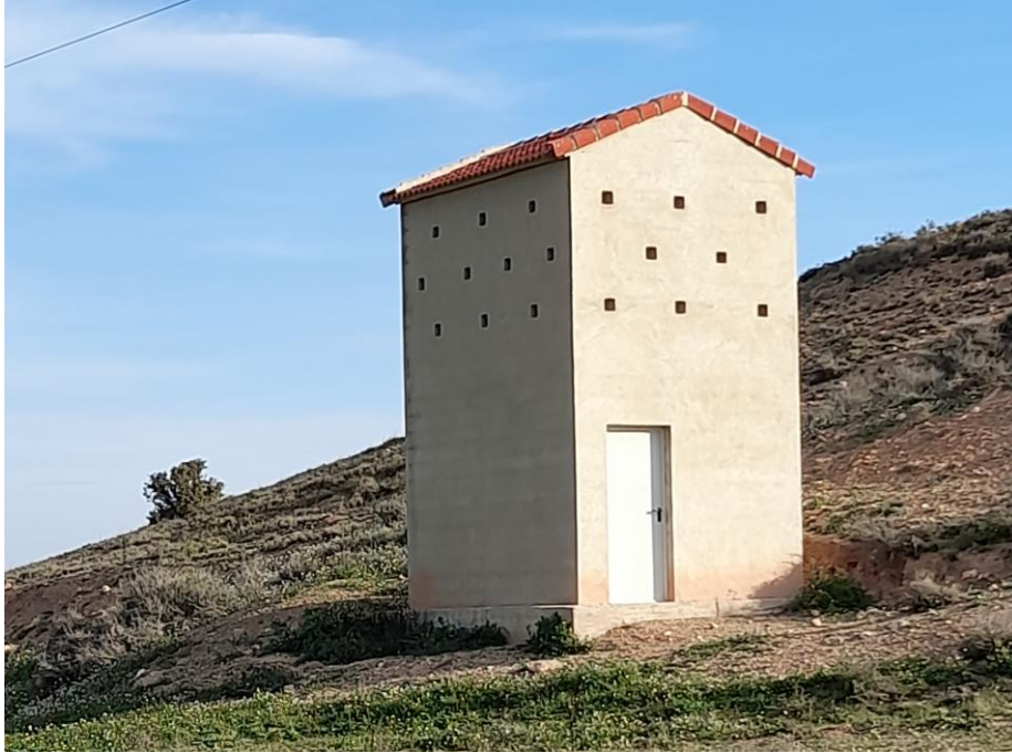
VJLN_FALNAU_4. Primillar de nueva construcción
