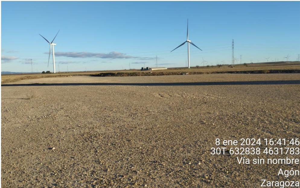
**Figura 34:** Plataforma de TIN-5 en correcto estado de conservación.
