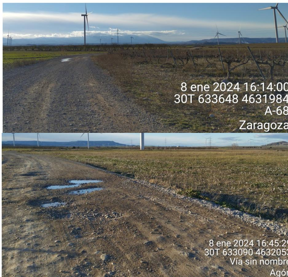
**Figura 35:** Cruce de viales entre a TIN\_06 y el resto de aerogeneradores 5 y 4 presenta algunos baches e irregularidades a causa del paso de vehículos.
