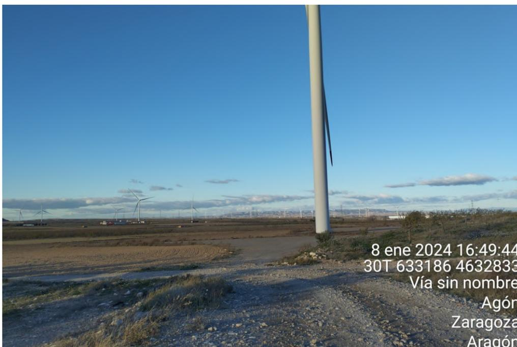
**Figura 39:** Vial de acceso a TIN-2, presenta cierto grado de erosión y baches debido a la escorrentía, así como cantos rodados que convendría restaurar para facilitar el paso de vehículos y la conservación del área.
