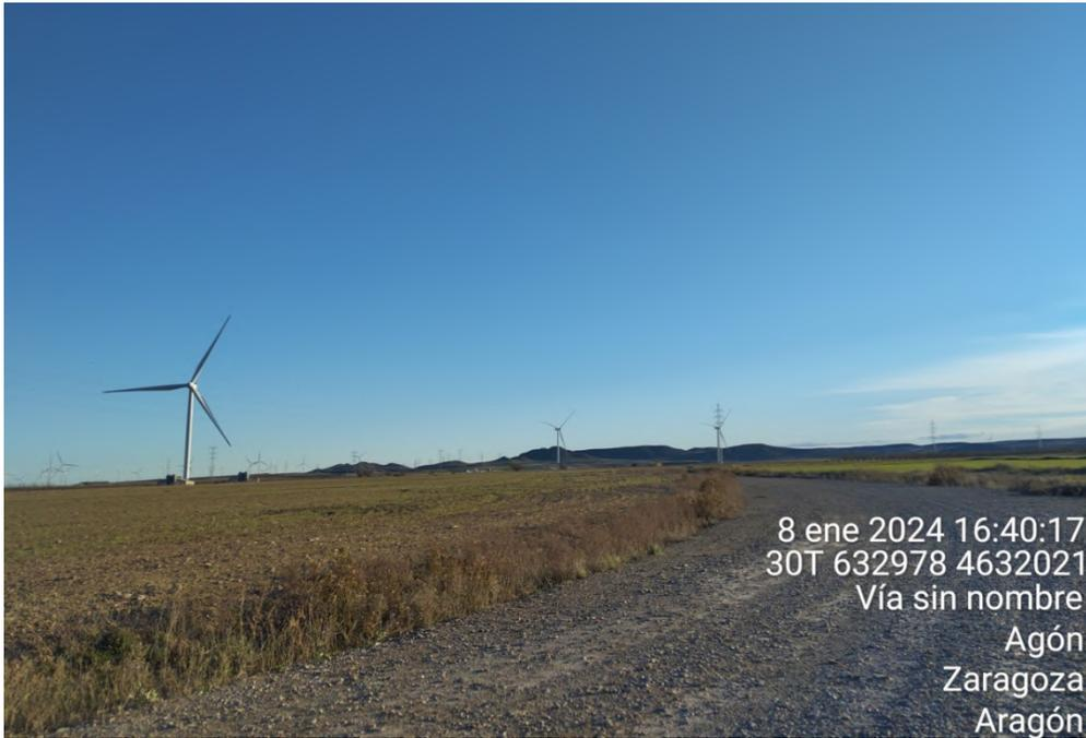
**Figura 33:** Vial de acceso a TIN\_05, está en buen estado, sin alteraciones por paso de vehículos o por adversidades meteorológicas.
