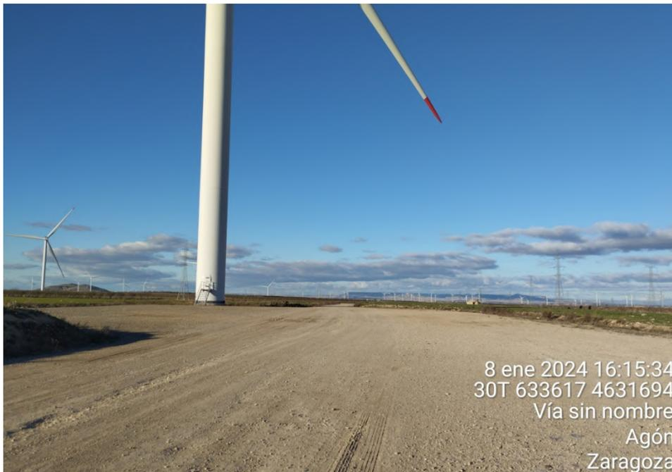
**Figura 30:** Plataforma de TIN-6 en correcto estado de conservación, salvo por algunos baches en su área central surgidos del paso de tráfico rodado.
