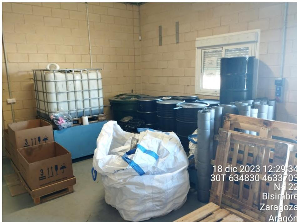
**Figura 41:** Interior del almacén de residuos de la SET, con los diferentes residuos peligrosos clasificados, aislados de la intemperie y sobre una tarima aislante para evitar posibles filtraciones al suelo.
