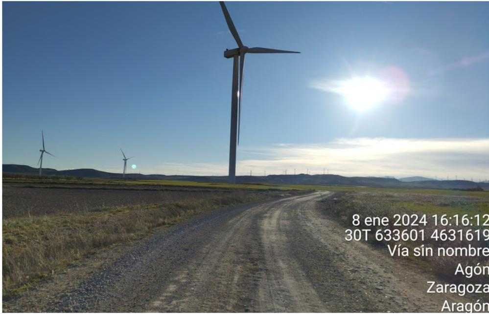
**Figura 31:** Vial de acceso a TIN\_07, está en buen estado, sin alteraciones por paso de vehículos o por adversidades meteorológicas.
