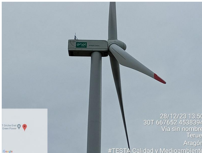
Fotografía 3 y 4: Barquillas de los aerogeneradores sin derrames de aceite y pintado de palas
