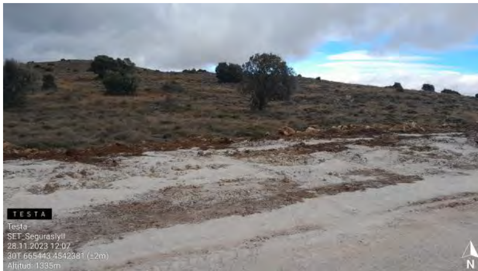
Mezcla de tierras y arena en tapado de zanja de evacuación cercano a vial de SE2-12.
