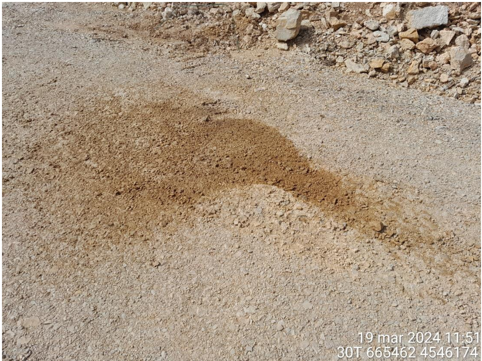
Derrame en vial acceso SE2-10 (NC)
