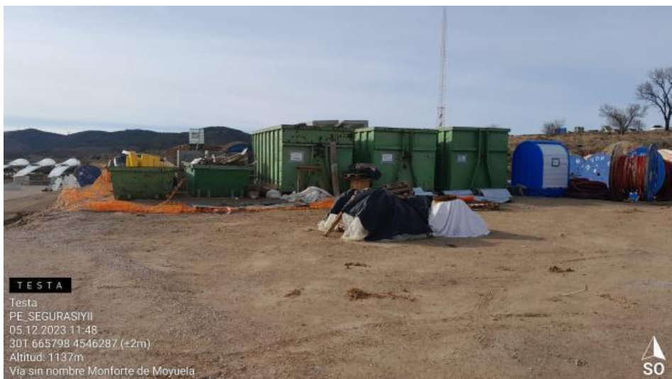
Contenedores RNP y punto limpio en mal estado.
