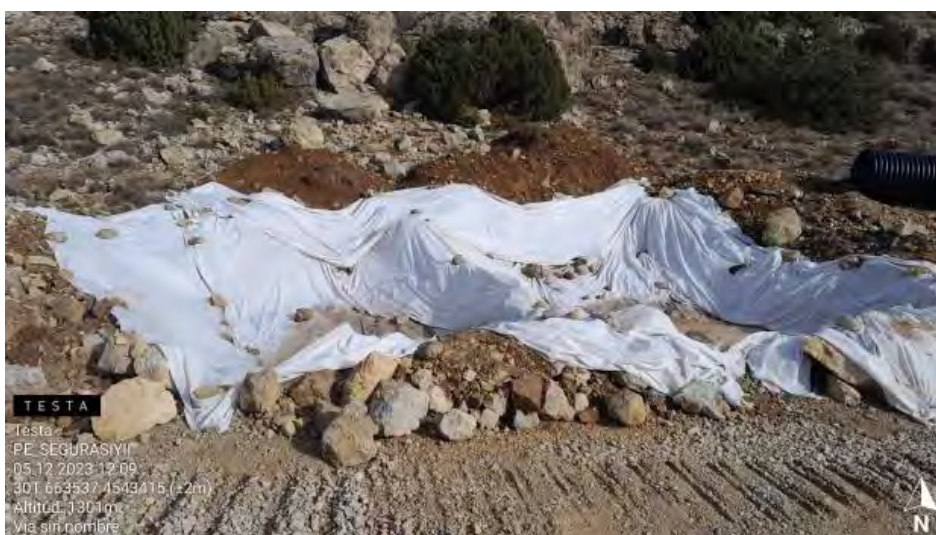
Nuevos pozos de lavado en SE2-12
