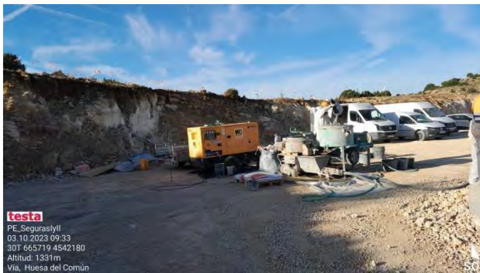
Aplicado de grout en SE2-14
