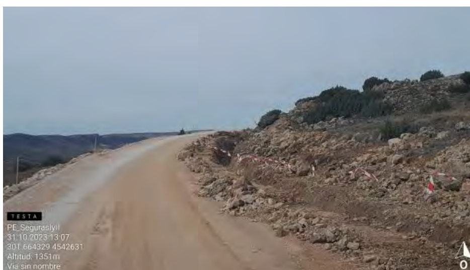
Zanja de evacuación en vial este.
