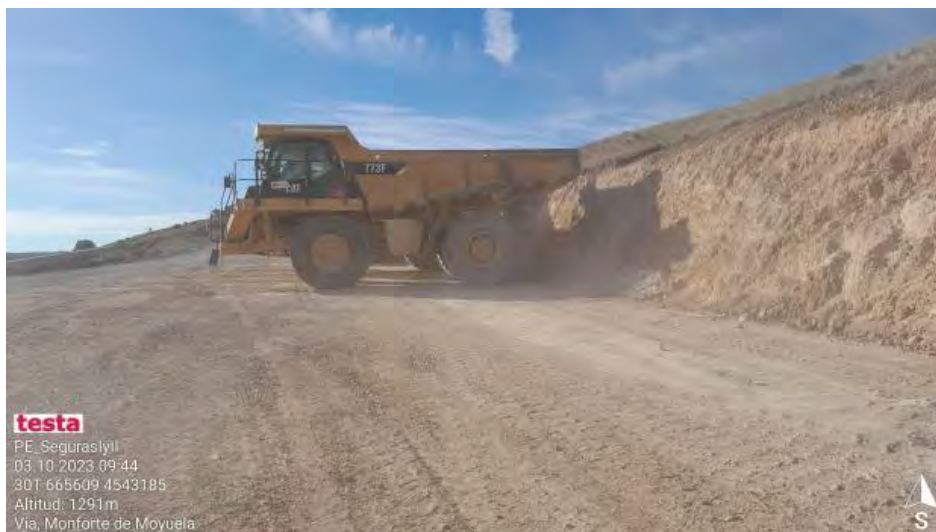
Limpieza de manchas de fugas en SE2-3
