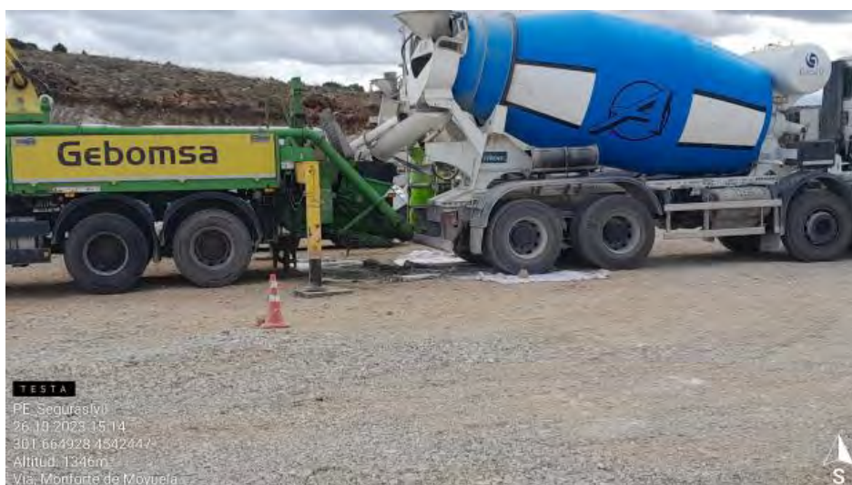
Hormigonado en SE2-1
