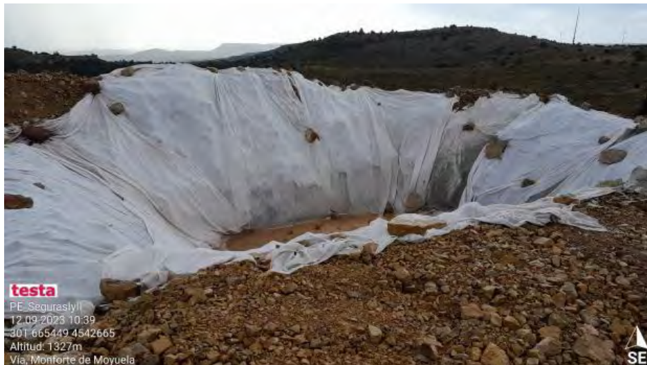
Pozo para siguiente hormigonado en SE2-14
