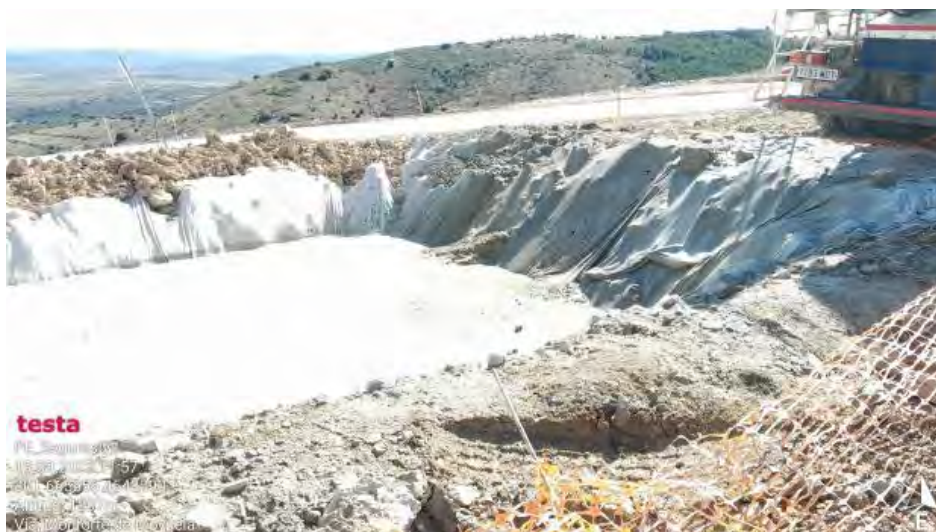
Pozo para hormigonado en SE2-3
