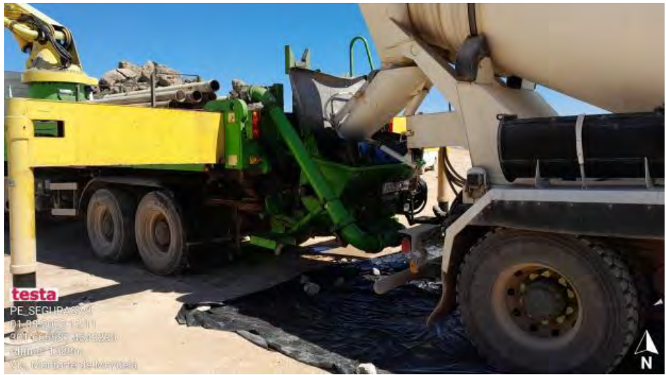
Hormigonado en SE2-3
