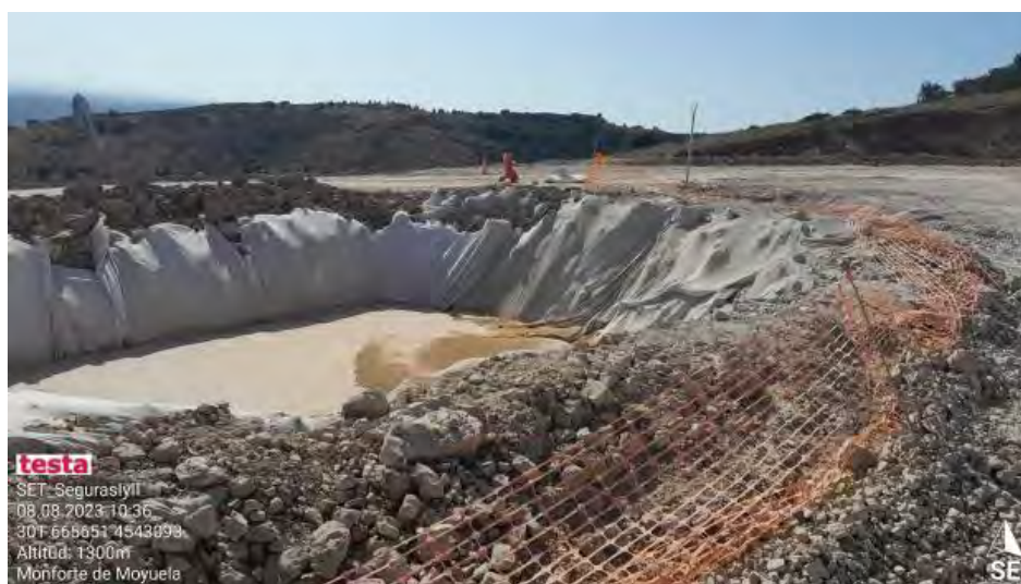
Reparación de balsa en SE2-3
