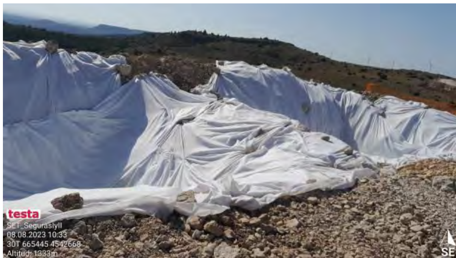
Nuevos pozos en SE2-2
