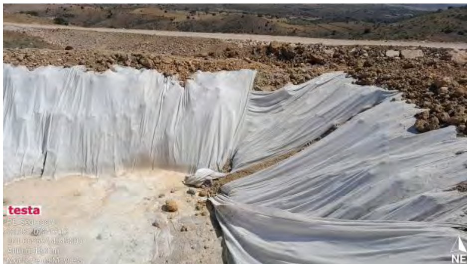
Pozo para su reparación en SE2-3
