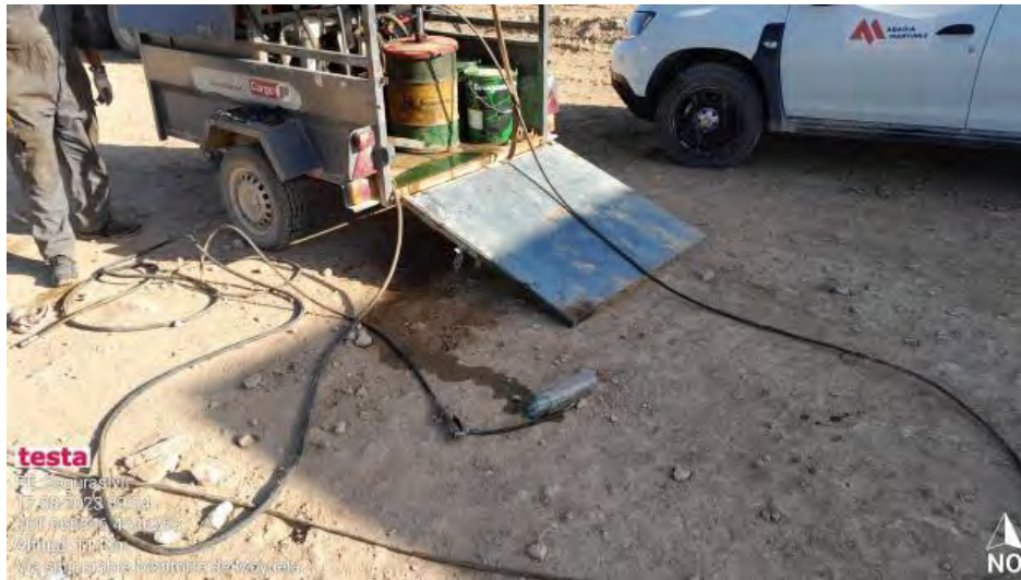
Derrames de líquidos en campa de acopio
