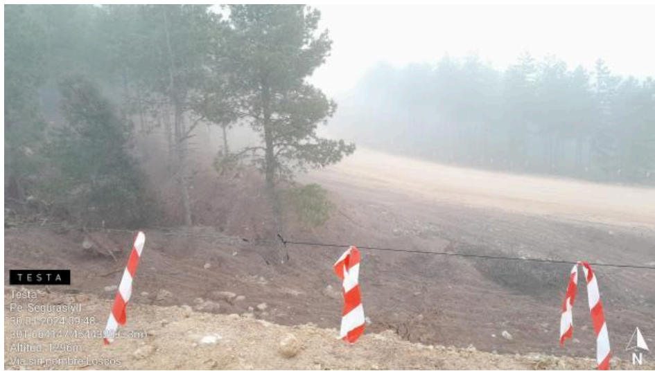
Tierra acopiada en acceso a SE1-2
