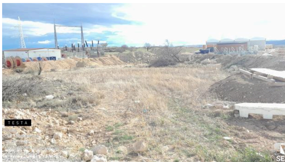
Residuos aledaños a vial entrada a SE1
