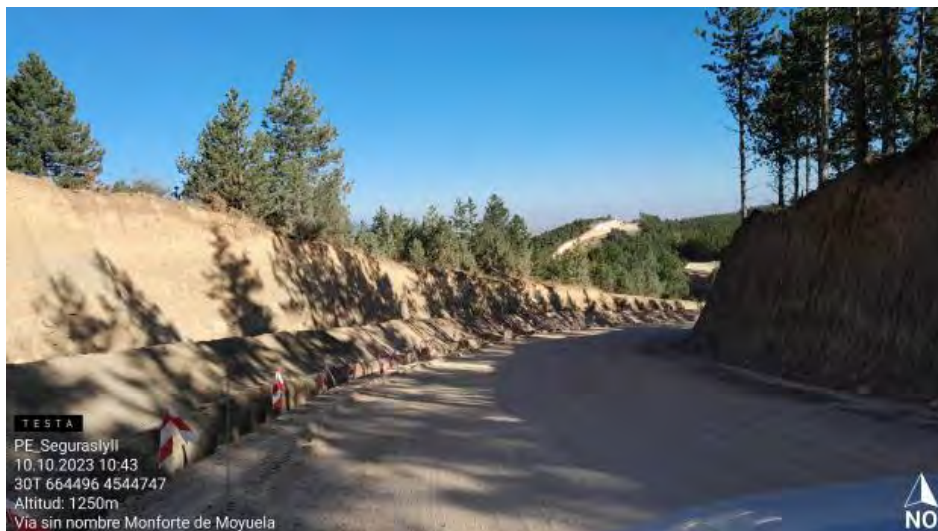
Zanja de evacuación en SE1
