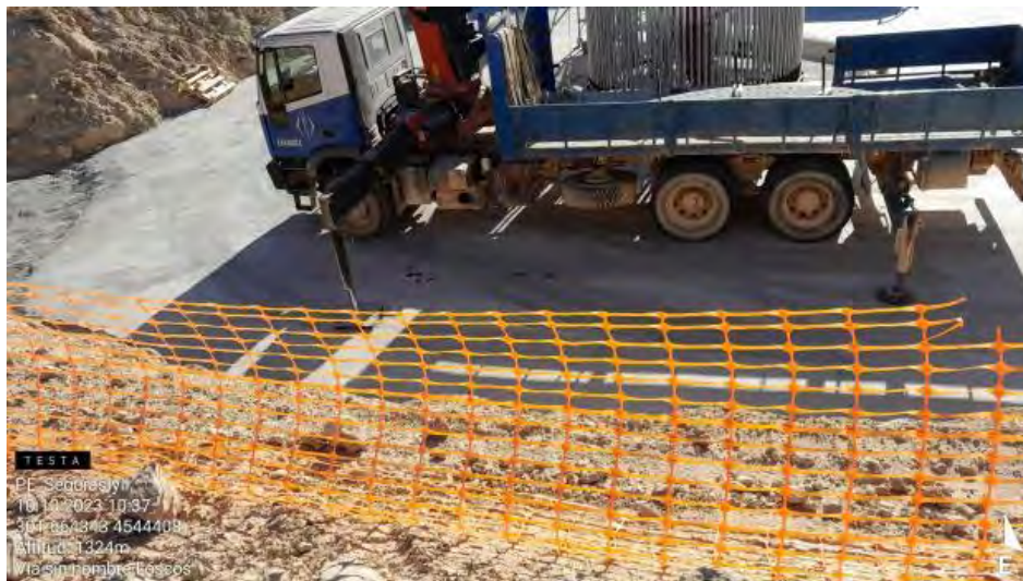
Montaje en SE1-2
