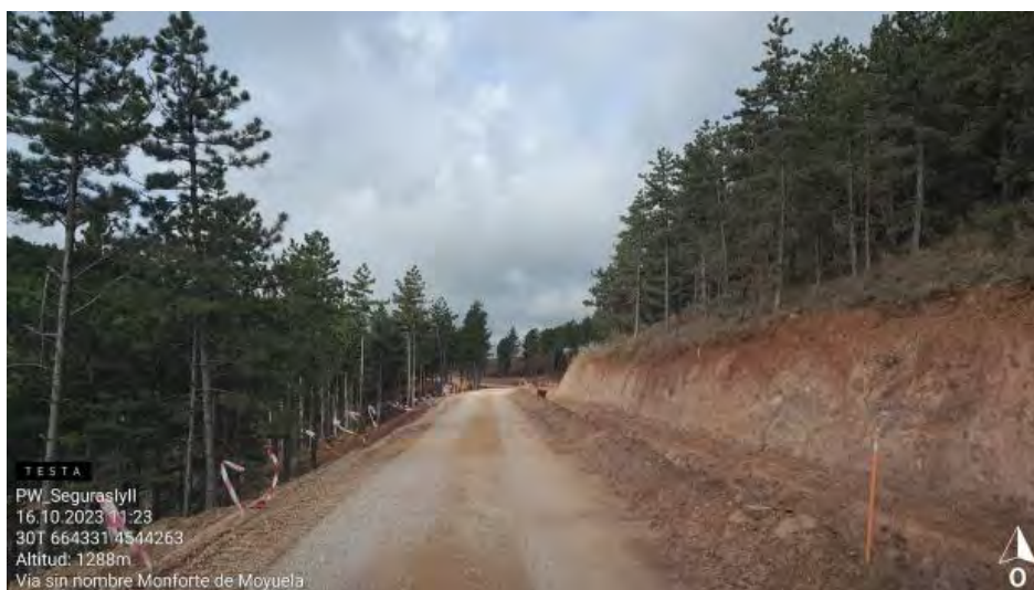
Zanja de evacuación en SE1
