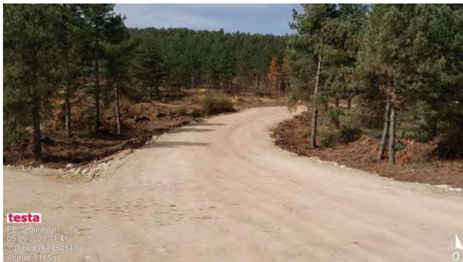
Adecuación de vial en entrada a Seguras 1
