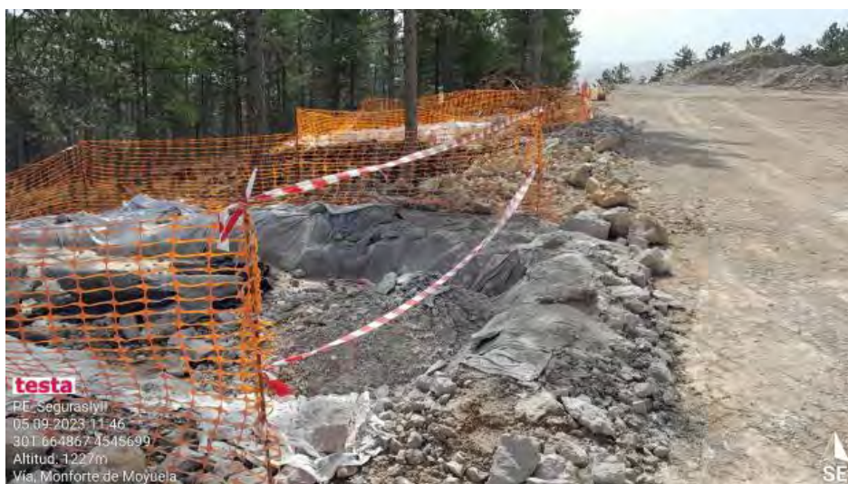
Pozo para su reparación en SE1-5
