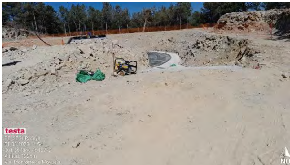
Grupo electrógeno sin protección de suelos en SE1-4
