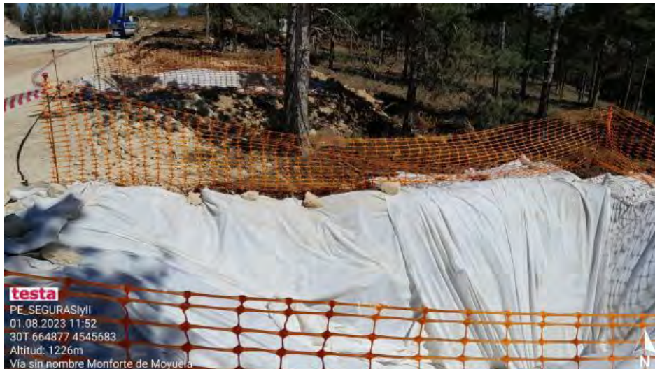
Nuevos pozos en SE1-4
