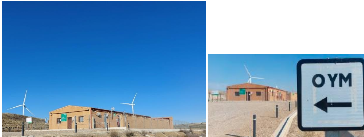
Fotografías 28 y 29: Edificio O&M y cartel
