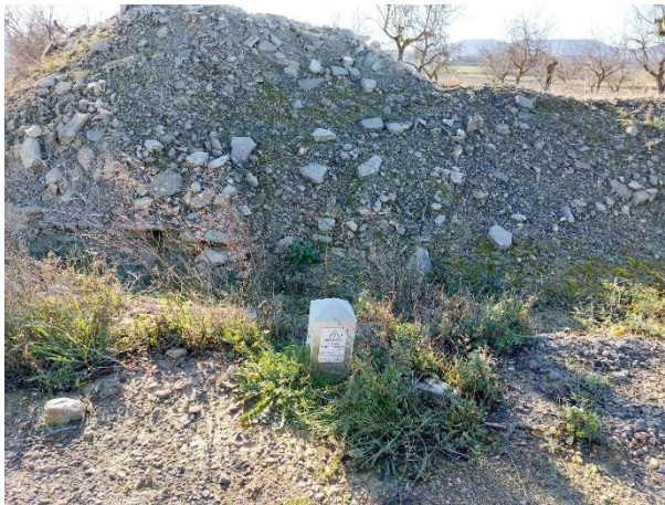
Fotografías 14 a 15: Señalización línea subterránea
