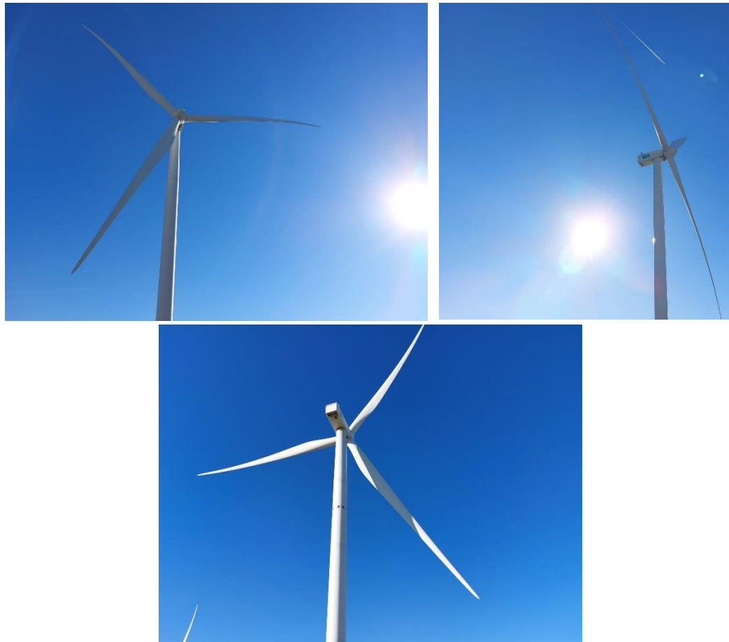
Fotografías 5 a 7: Barquillas de los aerogeneradores sin derrames de aceite
