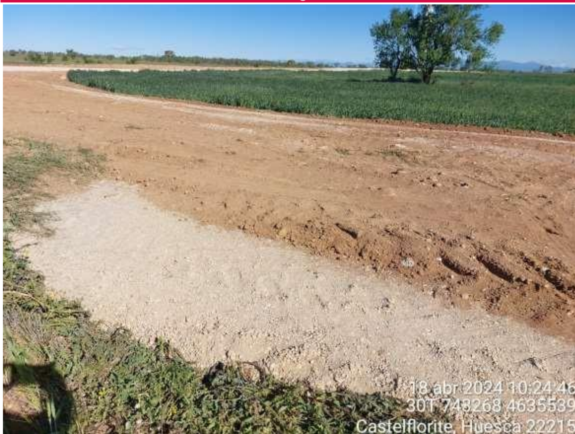
Imagen 1. Primeros trabajos de restauración ambiental en SC2.
