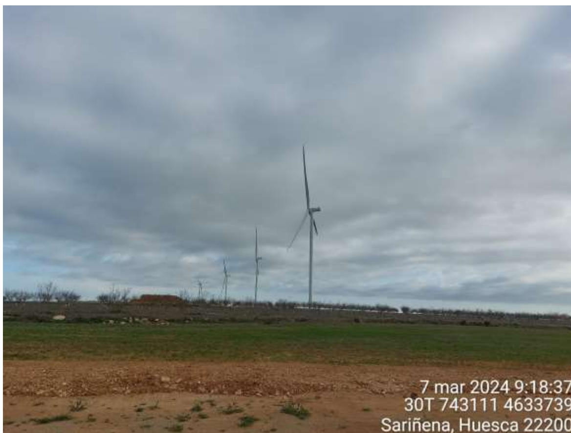
Imagen 1. Parques eólicos SC2 y SCA.
