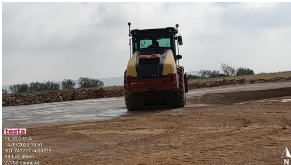
Trabajos en SC2
