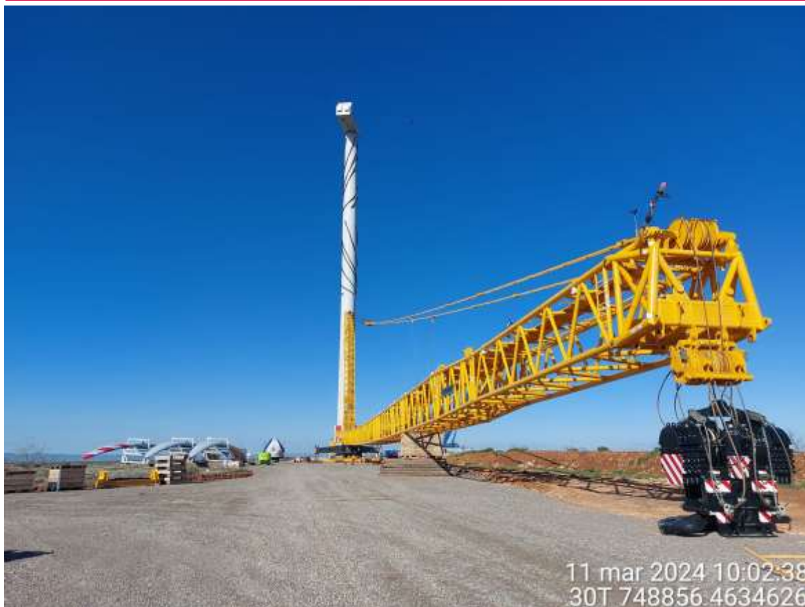
Imagen 1. Montaje de SC1-03.
