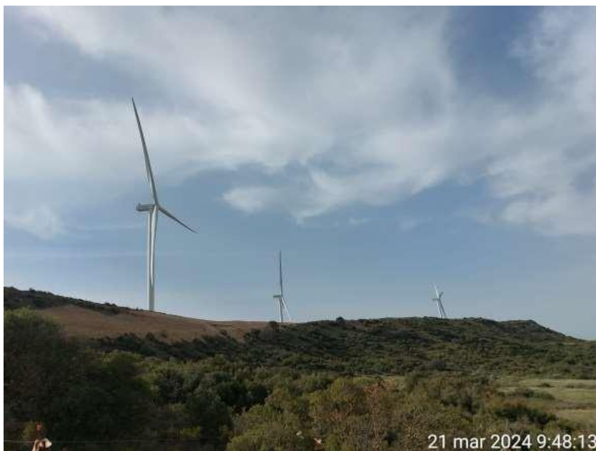
Imagen 2. SC1 con el montaje finalizado.
