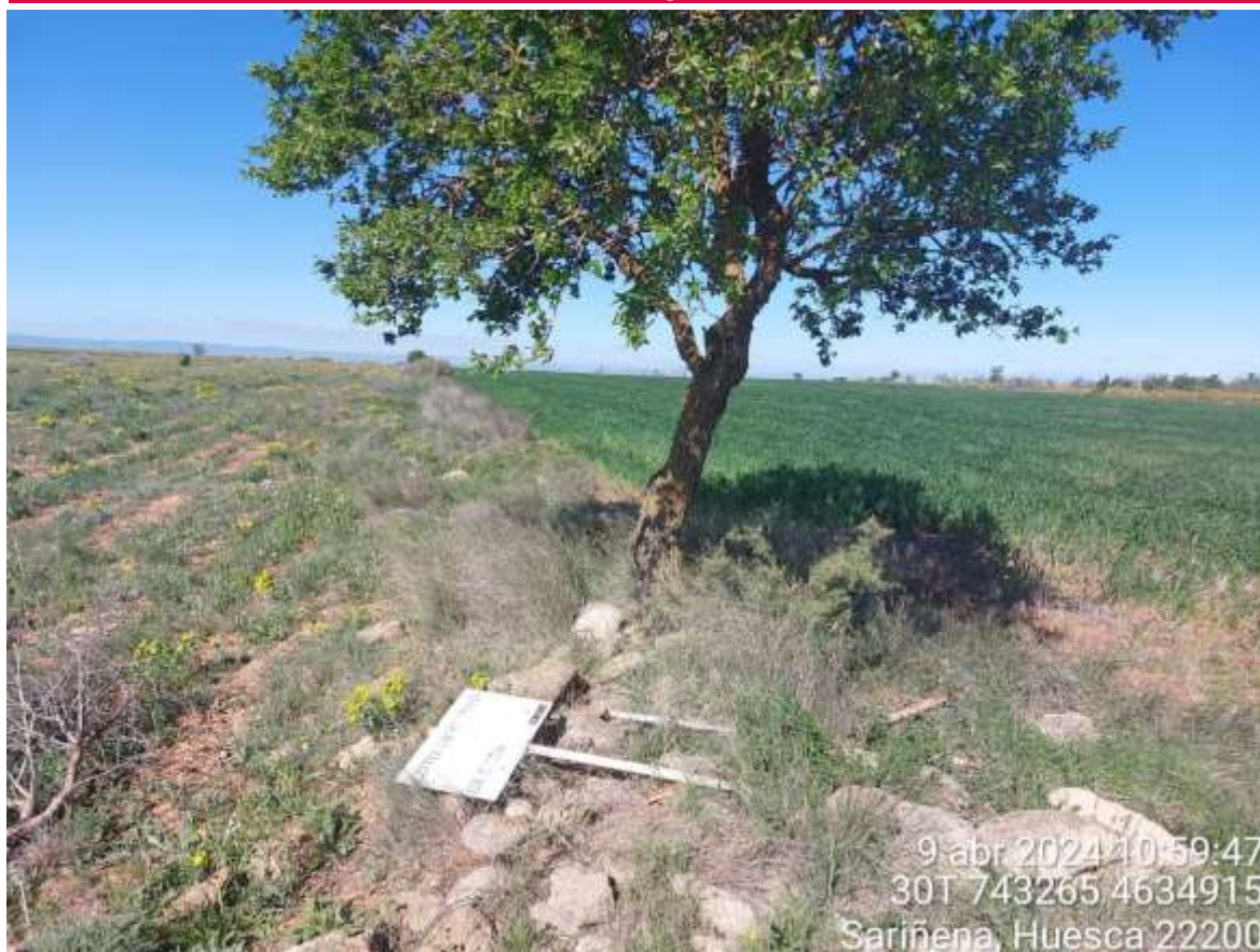
Imagen 1. Cartelería que debe volver a ser colocada.
