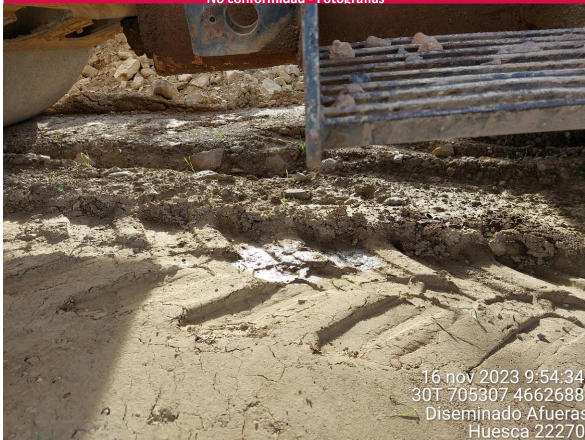
Imagen 1. No conformidad grave. Fuga en maquinaria aparcada sin protección del suelo.
