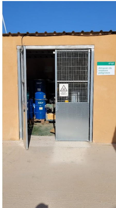
Fotografía 25: Almacenamiento de residuos peligrosos
