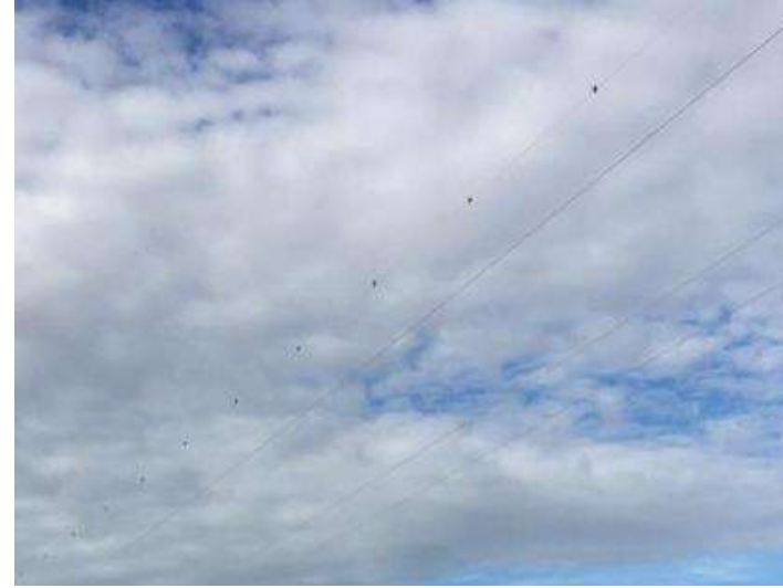
Fotos 24 y 25: Detalle de los dispositivos salvapájaros
