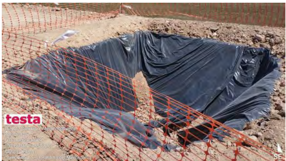
Nuevos pozos en avance de obra correctos
