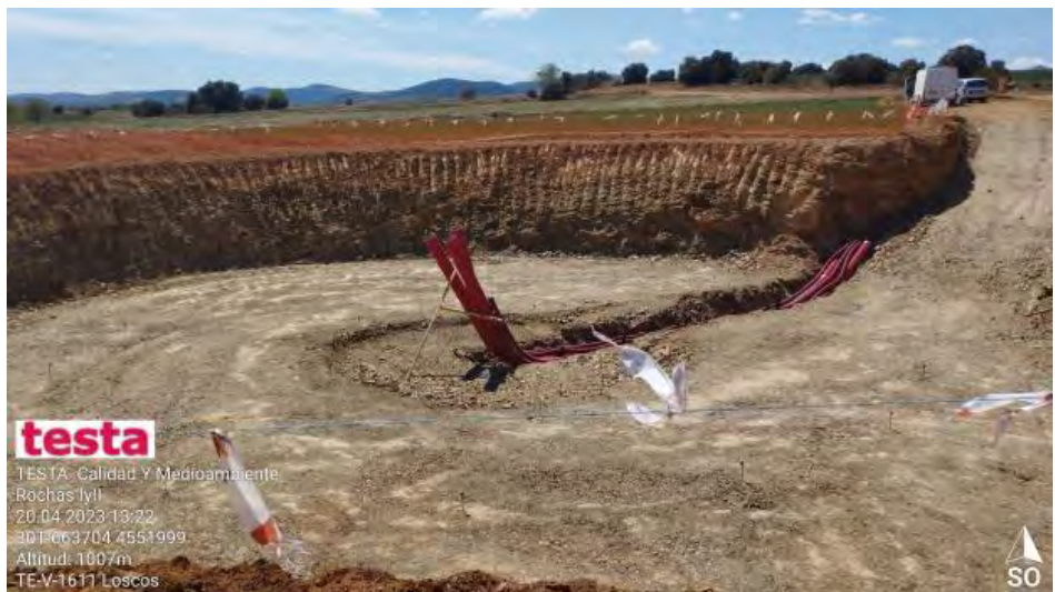
Avances en excavaciones
