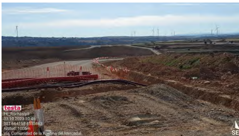
Trabajos en zona de RH2-4
