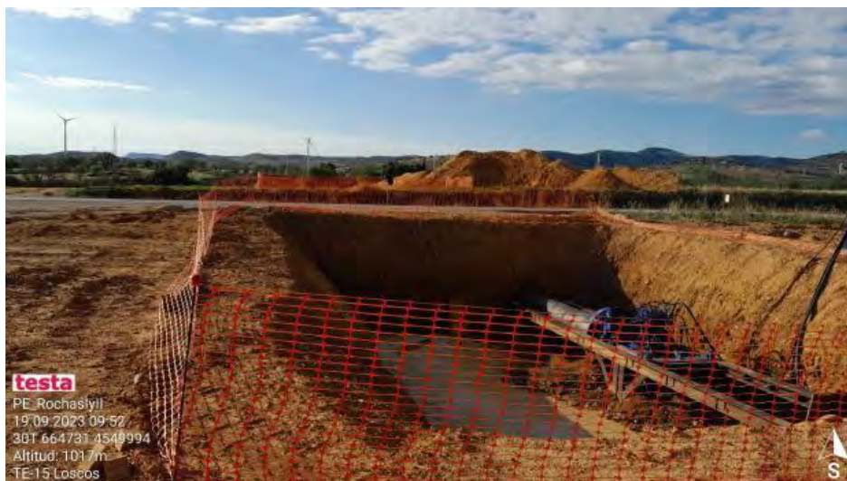
Paso de línea de evacuación bajo calzada.
