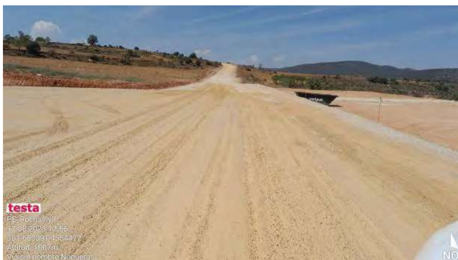
Riegos en viales y plataformas
