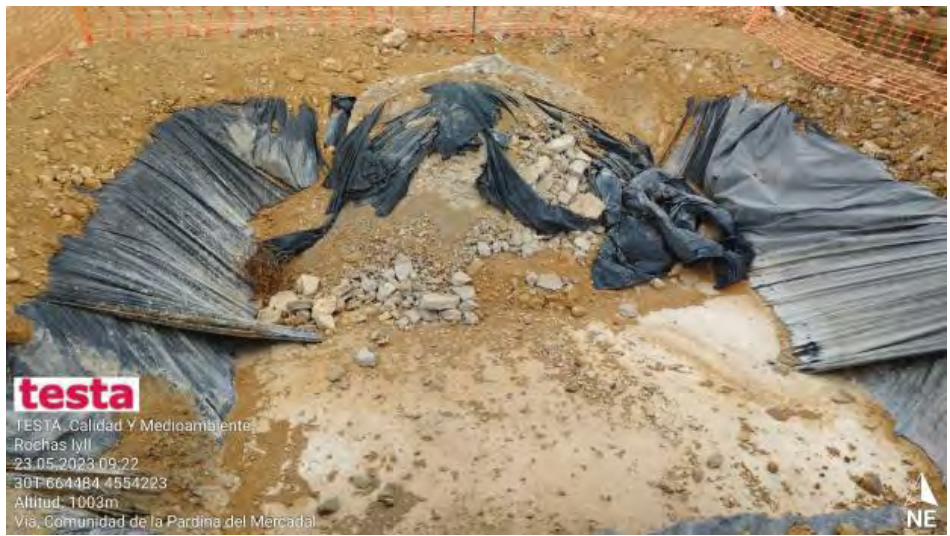
Pozo de lavado en mal estado.
