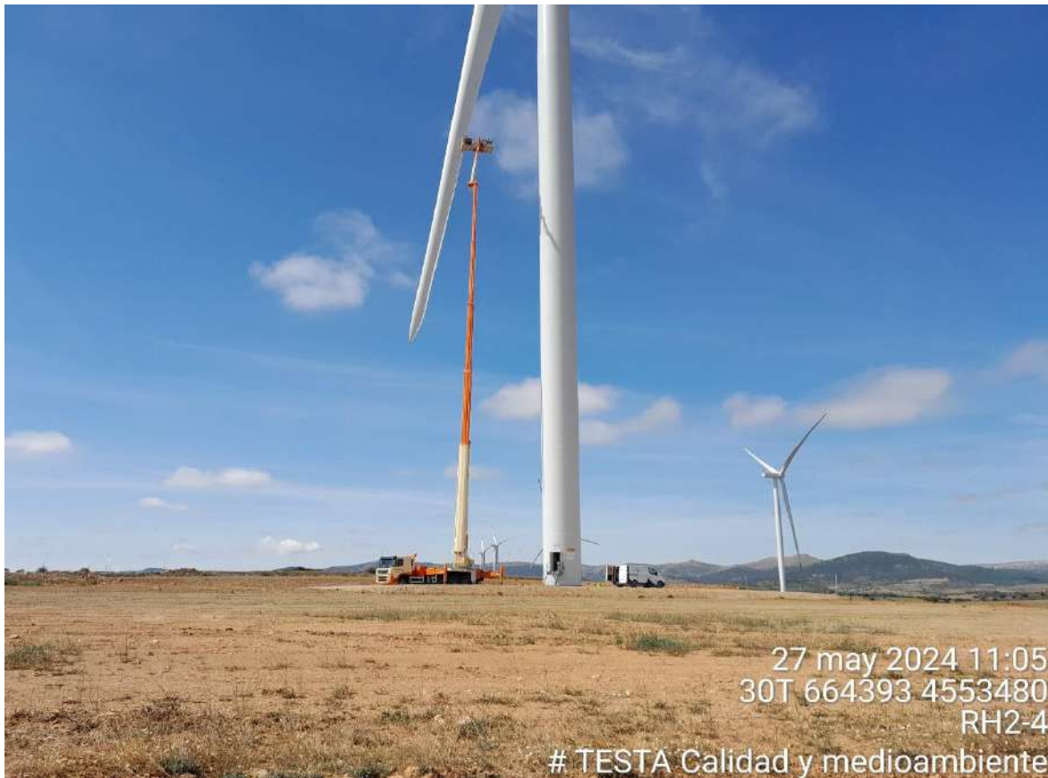
Imagen 1. Plataforma RH2-4. Reparación de palas.
