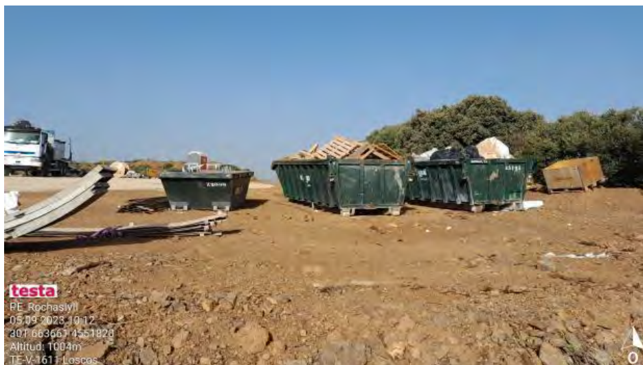
Adecuación de punto limpio.
