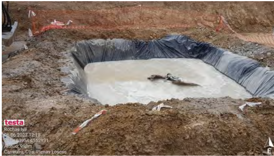
Pozo de lavado RH2-3 reparado
