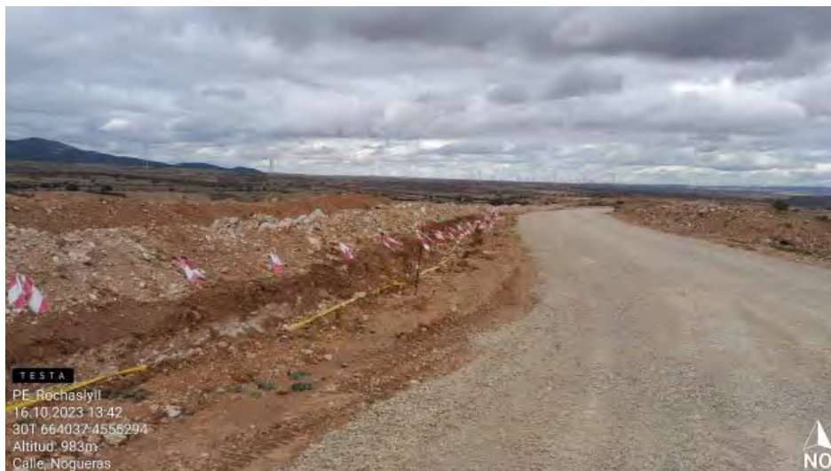
Zanja de evacuación
