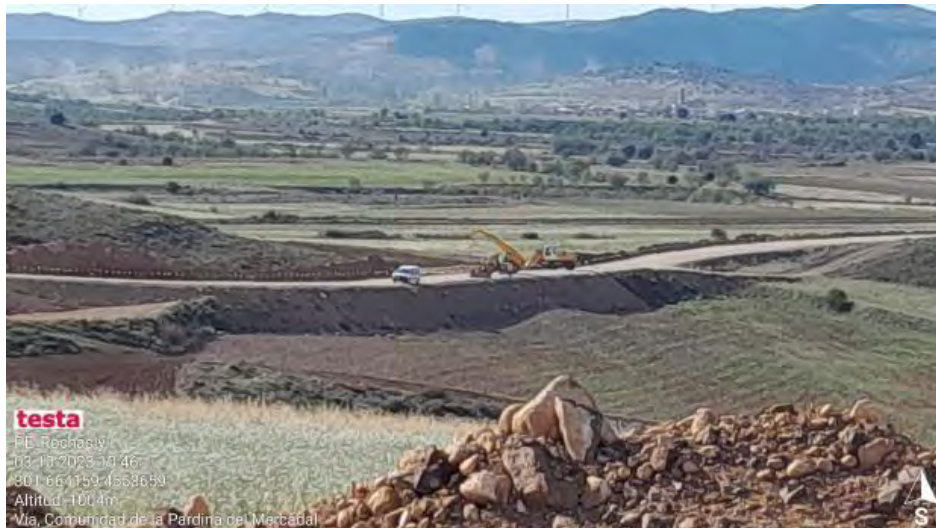
Tendido de cable en vial
