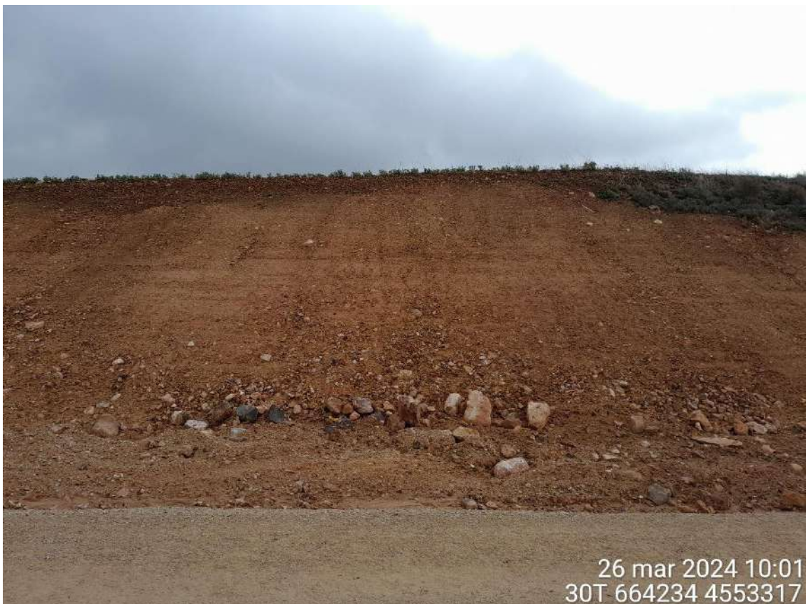
Talud tras realizar hidrosiembra en RH2-04-
