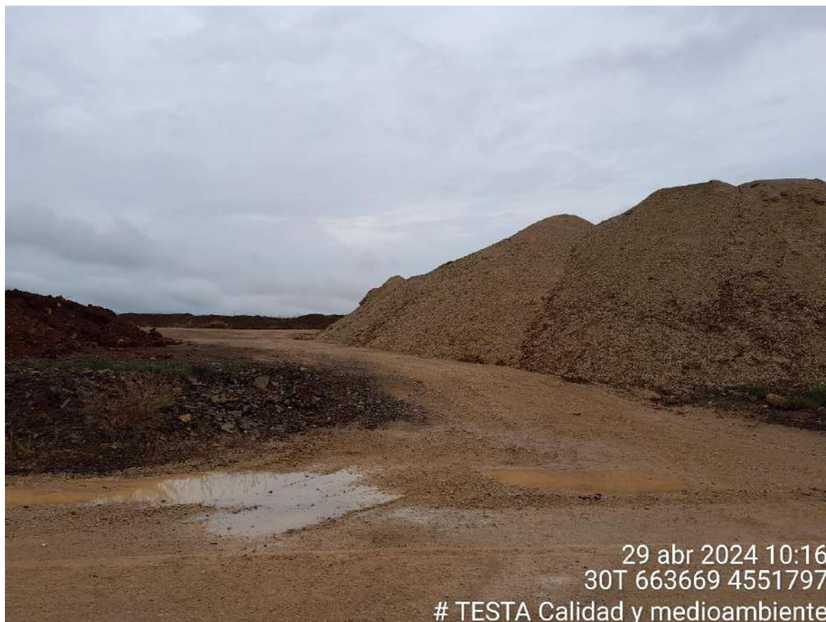
Imagen 1. Acopio junto al vial de acceso a RH2-1
