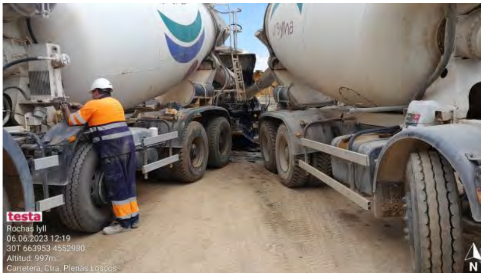
Aislamiento de suelo en bombeo de hormigón
