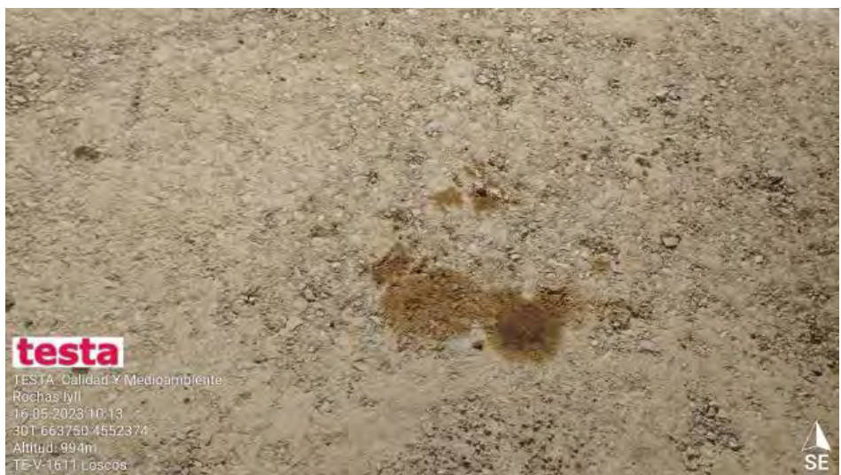
Derrame II en punto limpio
