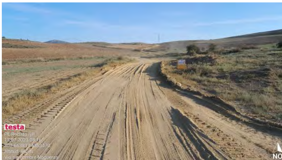
Acumulaciones de polvo en tramos concretos de los viales.
