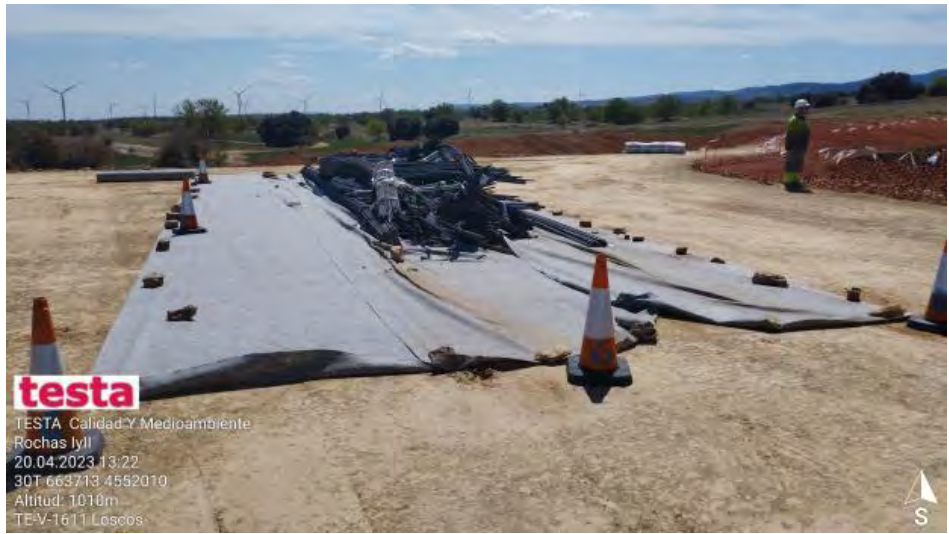
Acopio de hierros zapata.
