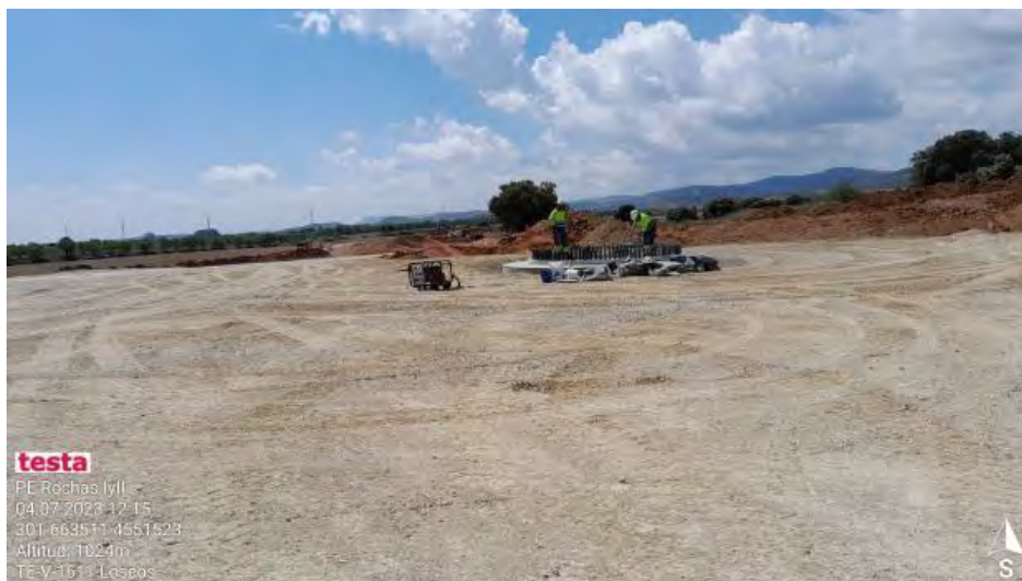
Trabajos de revestimiento en RH2-1
