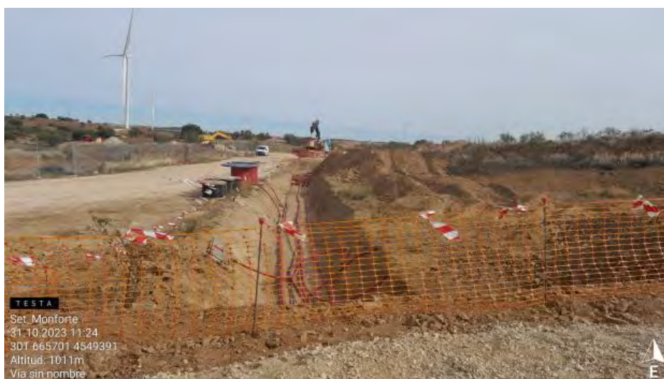
Tendido de cable en tramo SET monforte.
