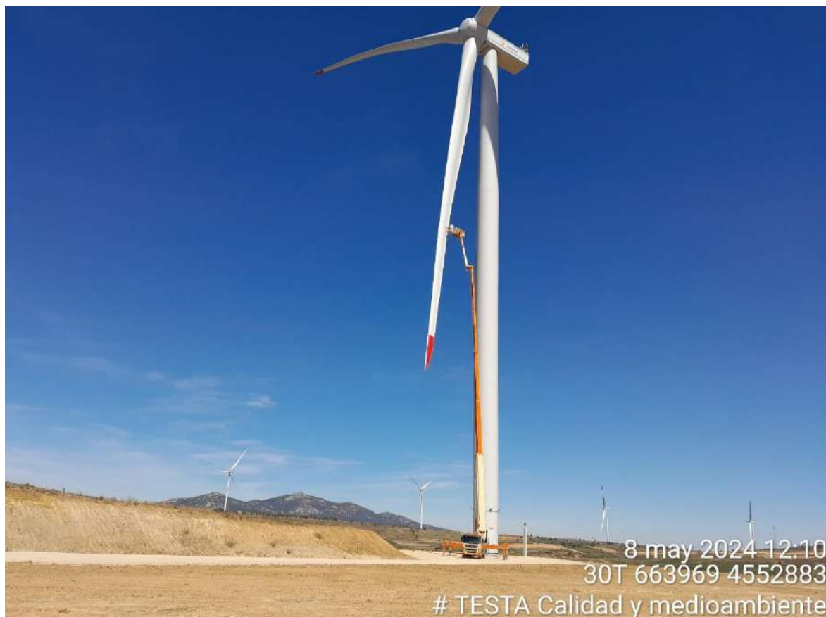
Imagen 1. Ajuste de palas en RH2-3
