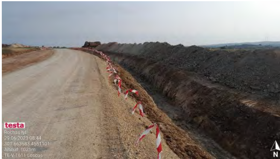
Separación de tierras en zanja de evacuación.
