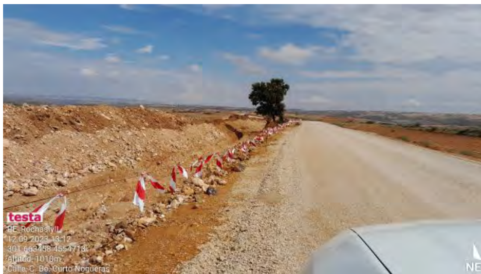
Zanja de evacuación ,separación de tierras.
