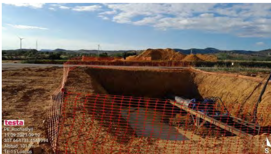
Paso de línea de evacuación bajo calzada.
