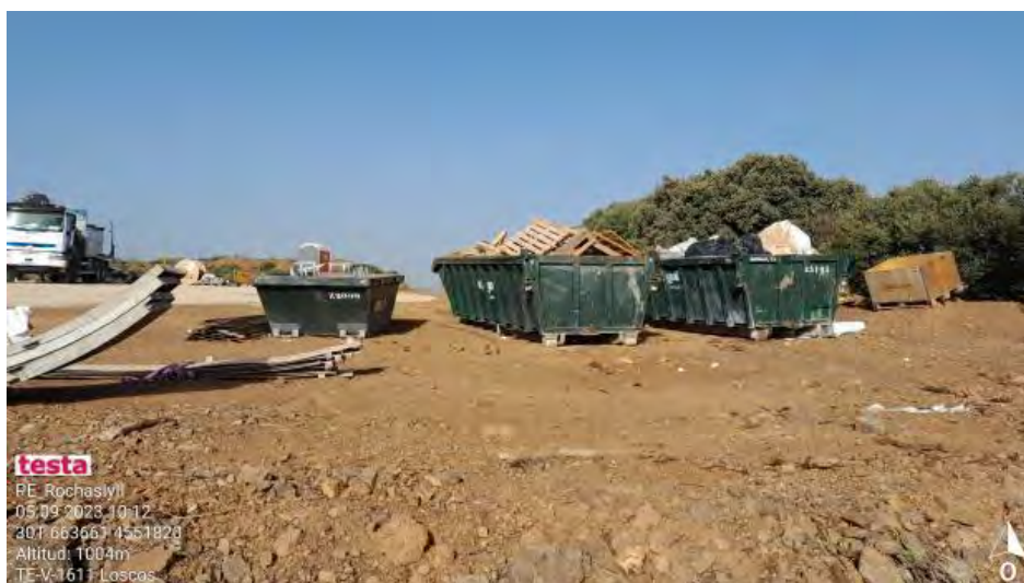
Adecuación de punto limpio.
