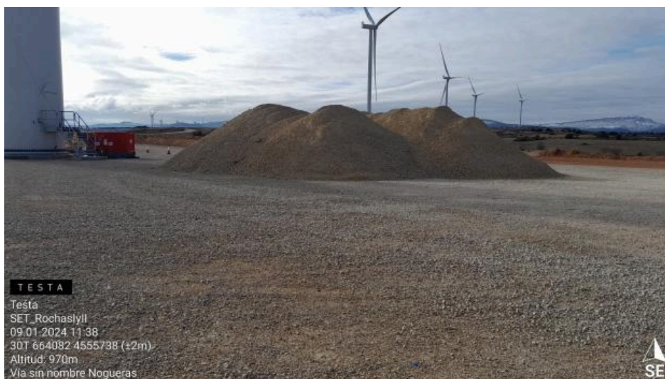
Retirada de zahorra en plataforma RH1-8
