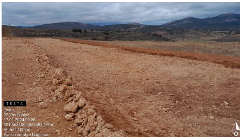
restauración en RH1-5
