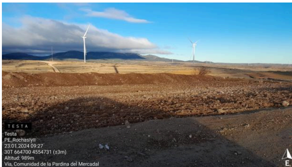
Restauración en RH1-6
