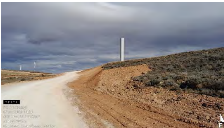
Tapado de zanja de evacuación y extendido de tierra vegetal .
